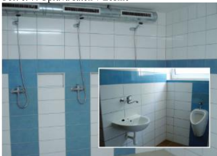
Obr. č. 7: Úprava šaten v Losiné
