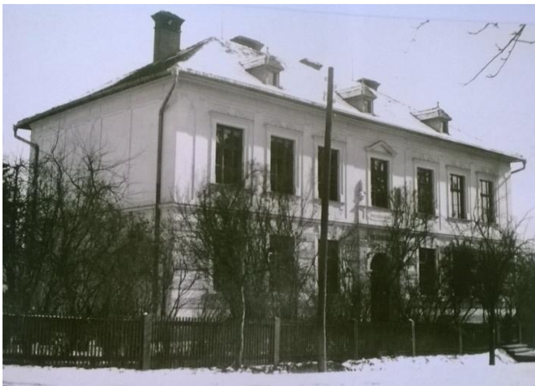
Obrázek 12: Budova bývalé školy
