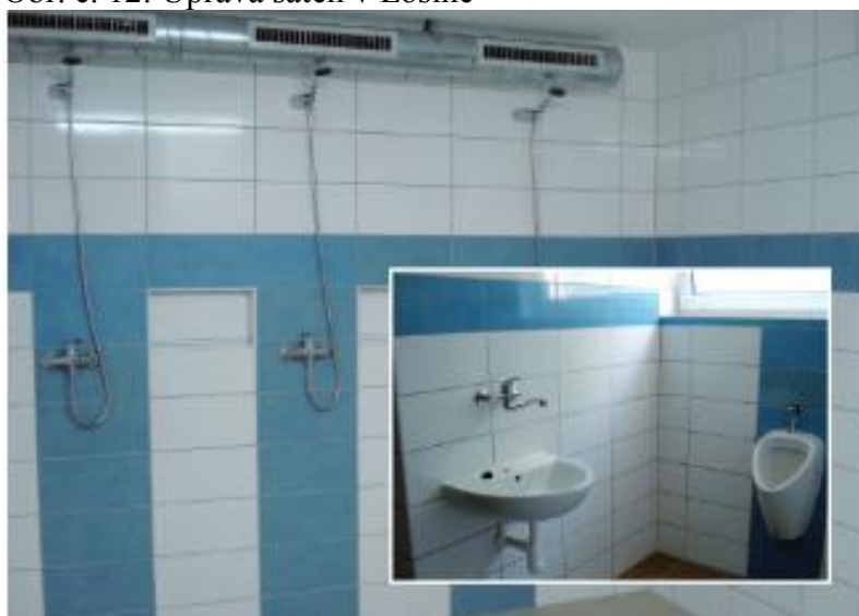
Obr. č. 12: Úprava šaten v Losiné
