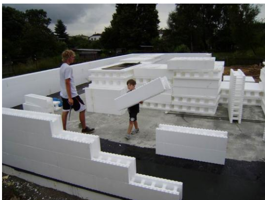
Obrázek 45: Ukázka výstavby z lehkého polystyrenového ztraceného bednění Thermomur 25
