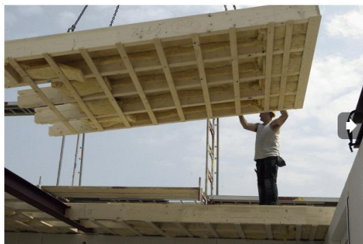
Obrázek 52: Ukázka osazování moderních prefabrikovaných stropních systémů
