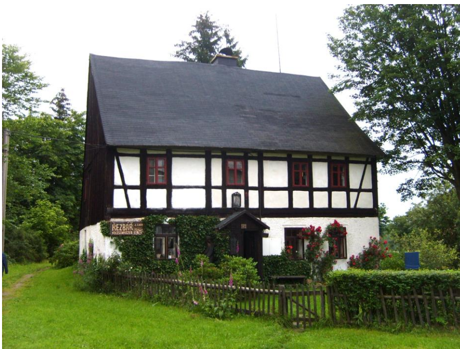
Obrázek 47: Hrázděná konstrukce v obci Abertamy
