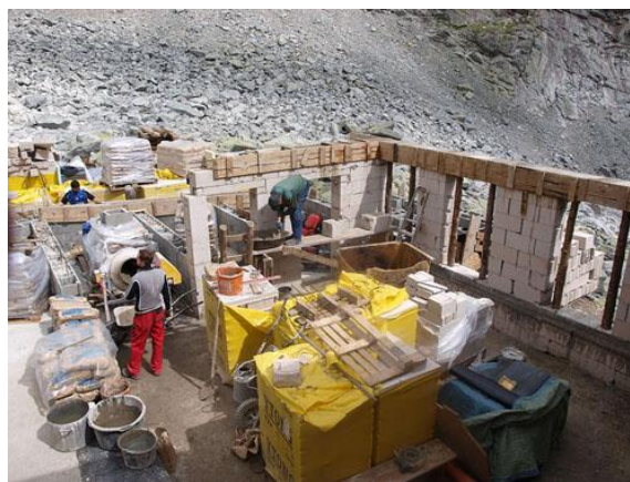
Obrázek 41: Výstavba pórobetonových stěn v nadmořské výšce 2250m n. m.
