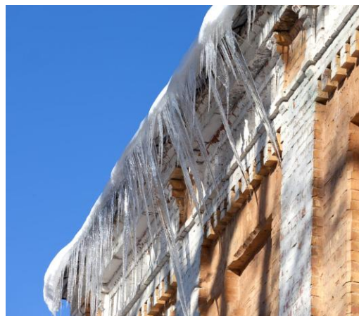
Obrázek 23: Vliv větru na tvorbu rampouchů
