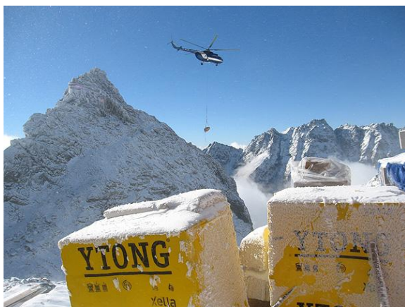
Obrázek 40: Doprava stavebního materiálu pomocí vrtulníku
