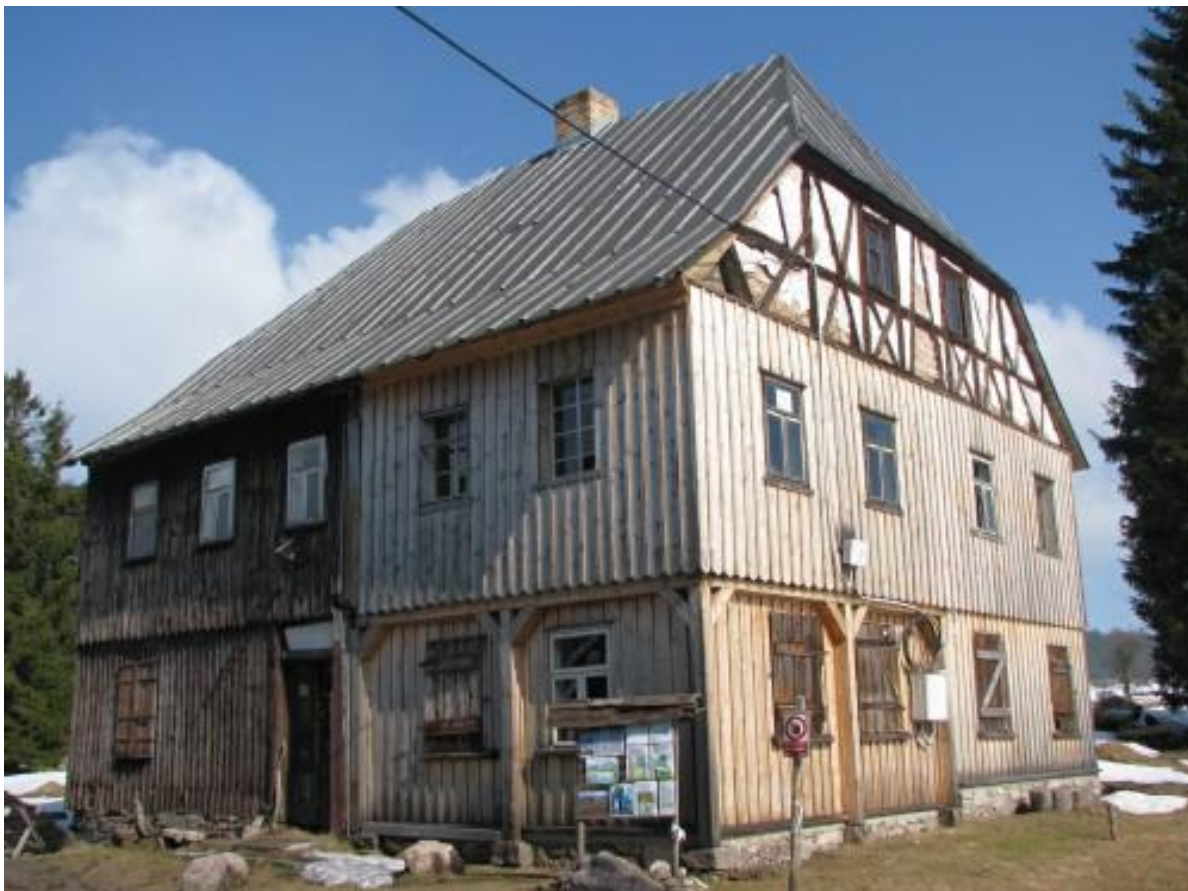
Obrázek 6: Dům v Přebuzi z 18. Století – kombinace roubené a hrázděné stavby na kamenném základu
