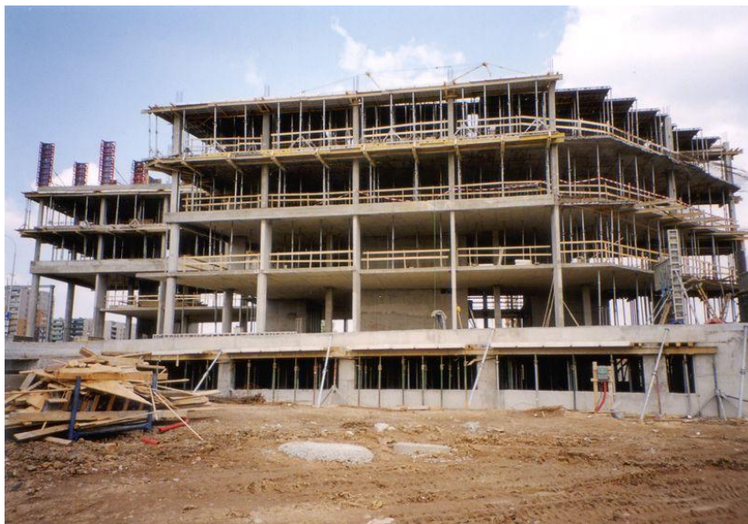
Obrázek 43: Železobetonový monolitický kombinovaný systém použitý pro výstavbu hotelu
