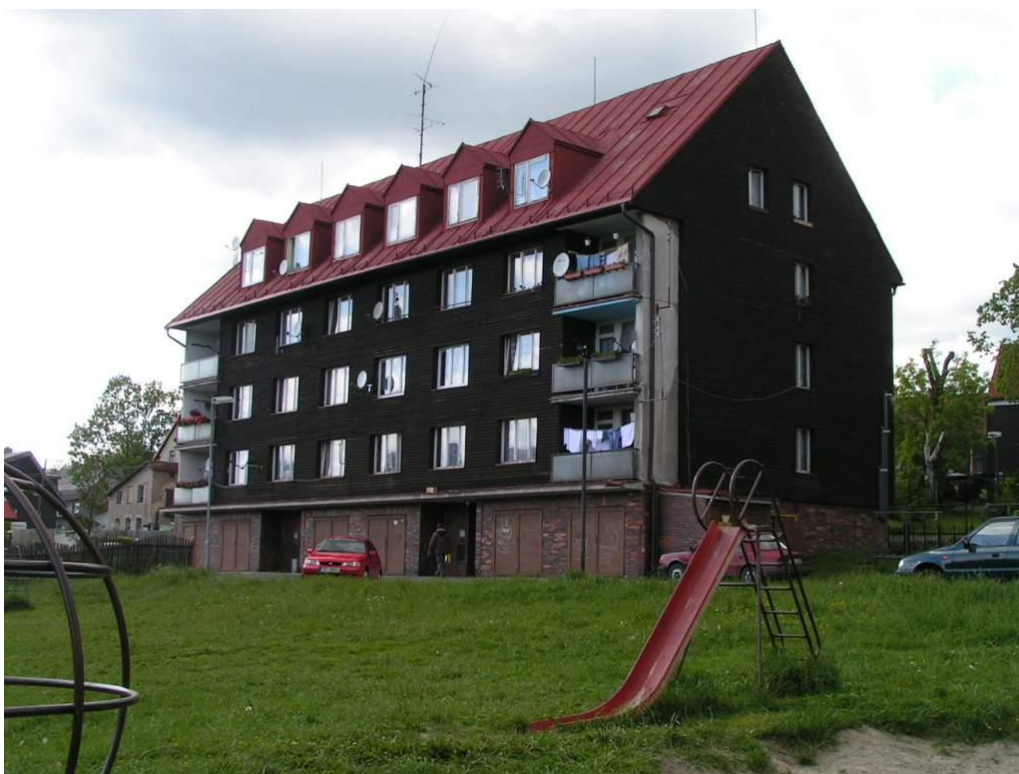
Obrázek 7: Panelový dům v obci Abertamy
