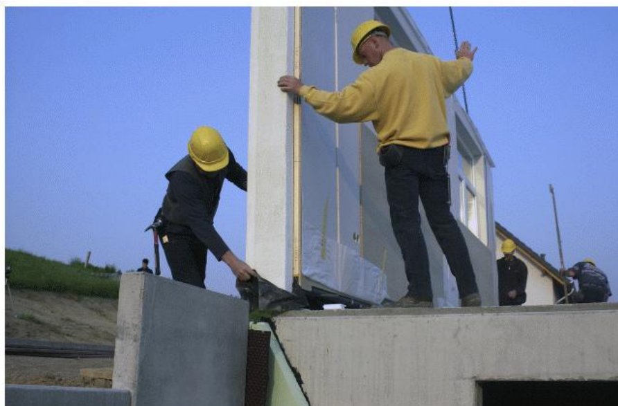
Obrázek 50: Ukázka postupu výstavby pomocí jeřábu
