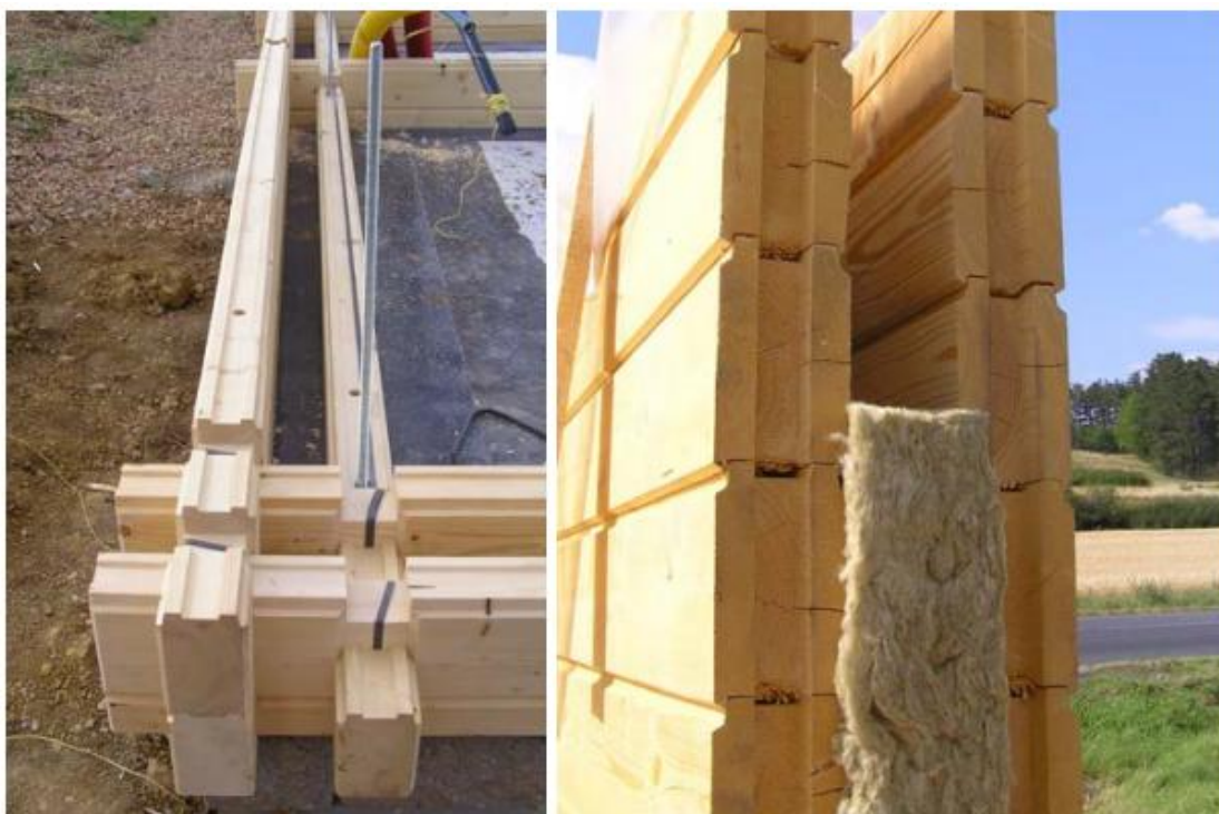
Obrázek 48: Sendvičový obvodový plášť roubené stěny
