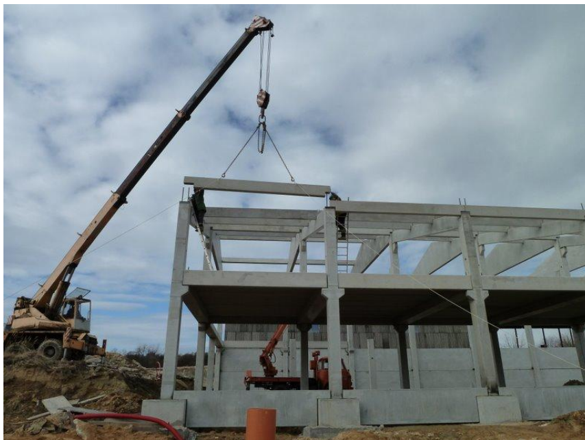
Obrázek 44: Ukázka výstavby betonové prefa-skeletové konstrukce
