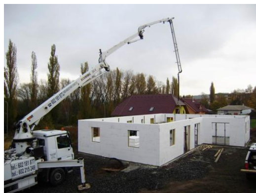
Obrázek 46: Způsob betonování systému Thermomur 25 pomocí betonového čerpadla
