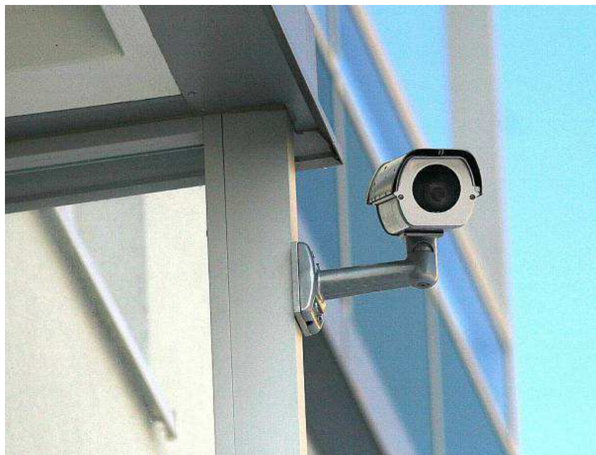
Obr. č. 7.3 – Ukázka umístění venkovní bezpečnostní kamery na fasádě objektu (zdroj: www.denik.cz )
