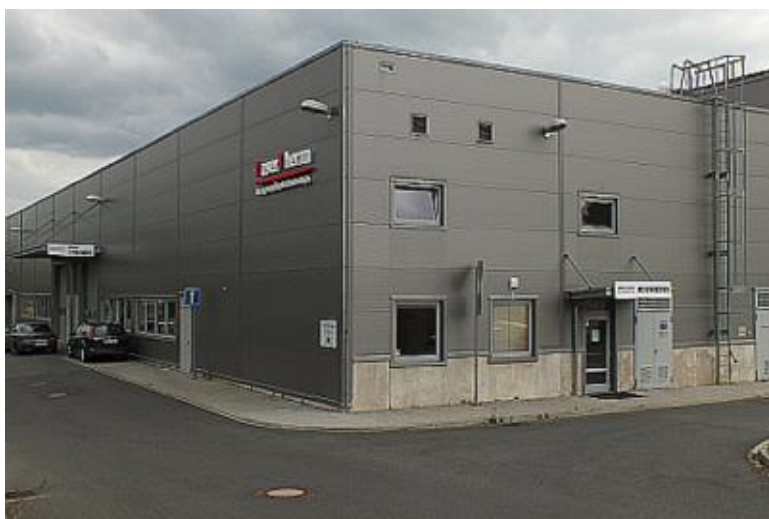
Obrázek 8: Plzeňská provozovna společnosti LaserTherm
