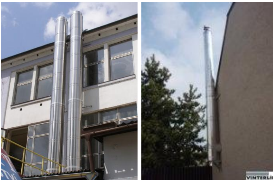
Obr. č.: 4 Třívrstvý komínový systém
