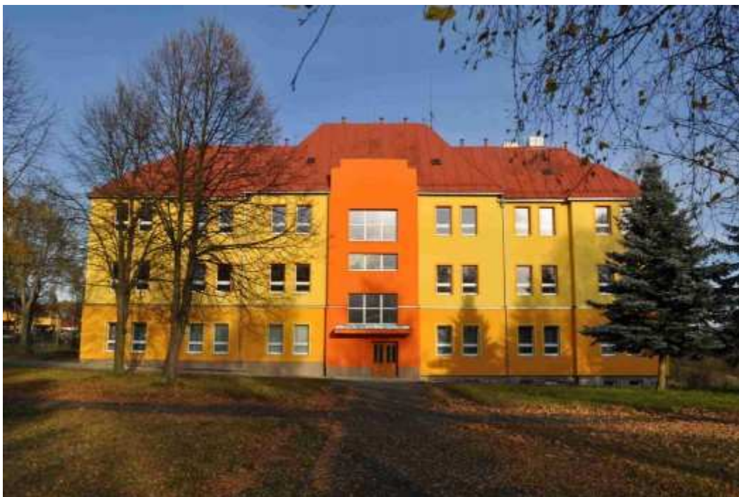
Základní škola v Teplé – budova I. stupně po rekonstrukci 2009
