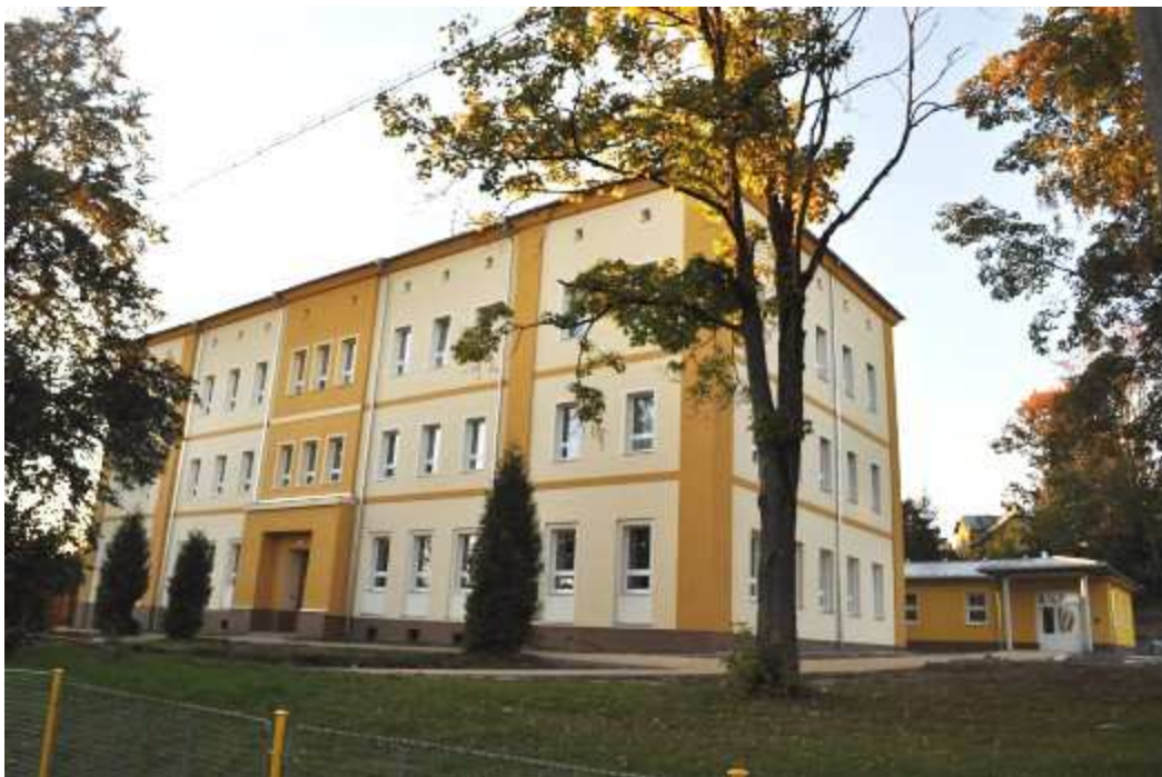
Základní škola v Teplé – budova II. stupně po rekonstrukci v roce 2011
