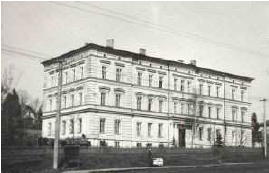
Budova Střední školy v Teplé – dnešní základní škola (budova II. stupně)
