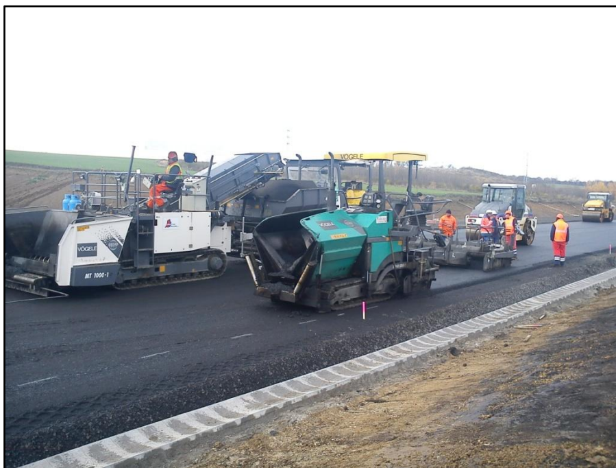
Obr. č. 2: Ukázka pokládky asphaltové směsi – rychlostní silnice R7 Chomutov
