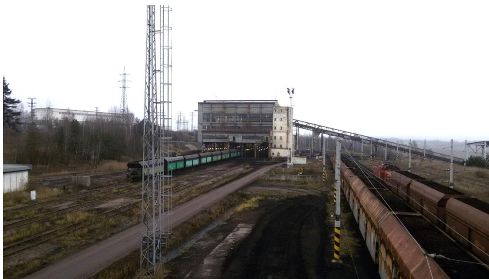
Obr. č. 12: Naložený vlak směřující k odběrateli
