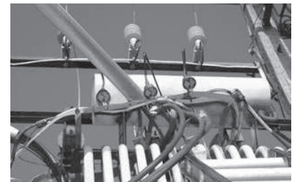
Ochrona transformatora 15/0,4 kV za pomocą SPD produkcji APATOR SA
