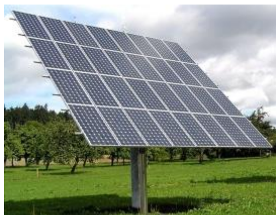
Obr. 3.11 Příklad instalace polohovatelných nosných prvků a) jednoosých, b) víceosých [8, 9]
