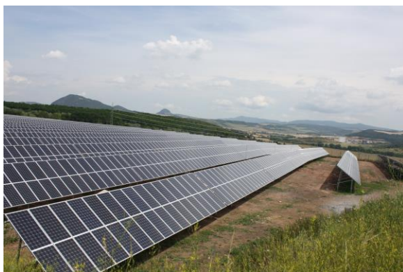
Obr. 3.10 Příklad instalace stacionárních nosných prvků na a) volných prostranstvích, b) střechách budov [6, 7]
