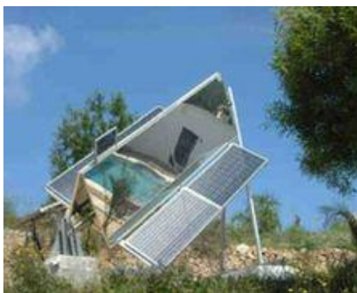
Obr. 3.11 Příklad instalace polohovatelných nosných prvků a) jednoosých, b) víceosých [8, 9]
