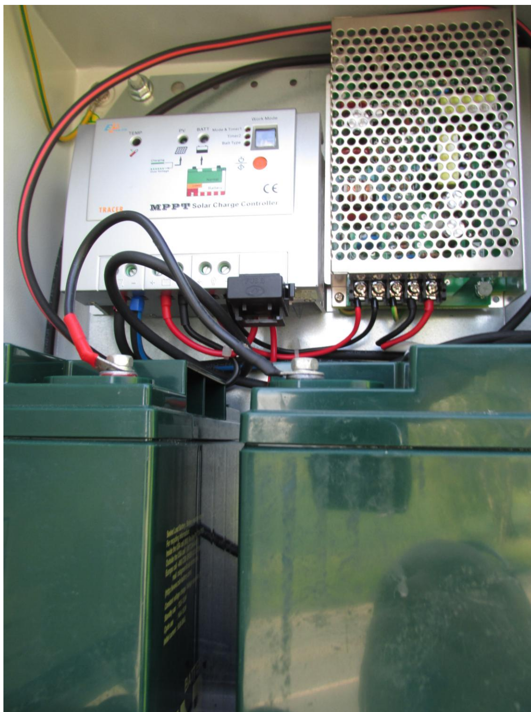
Obr. 24: Vlastní technické řešení – kontrolér pro řízení dobíjení akumulátorů, akumulátory a DC/DC měnič
