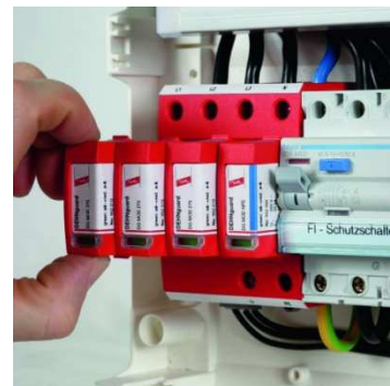
Obr. 2.8. Výměna varistorového modulu. V nezměněné podobě převzato z [17]
