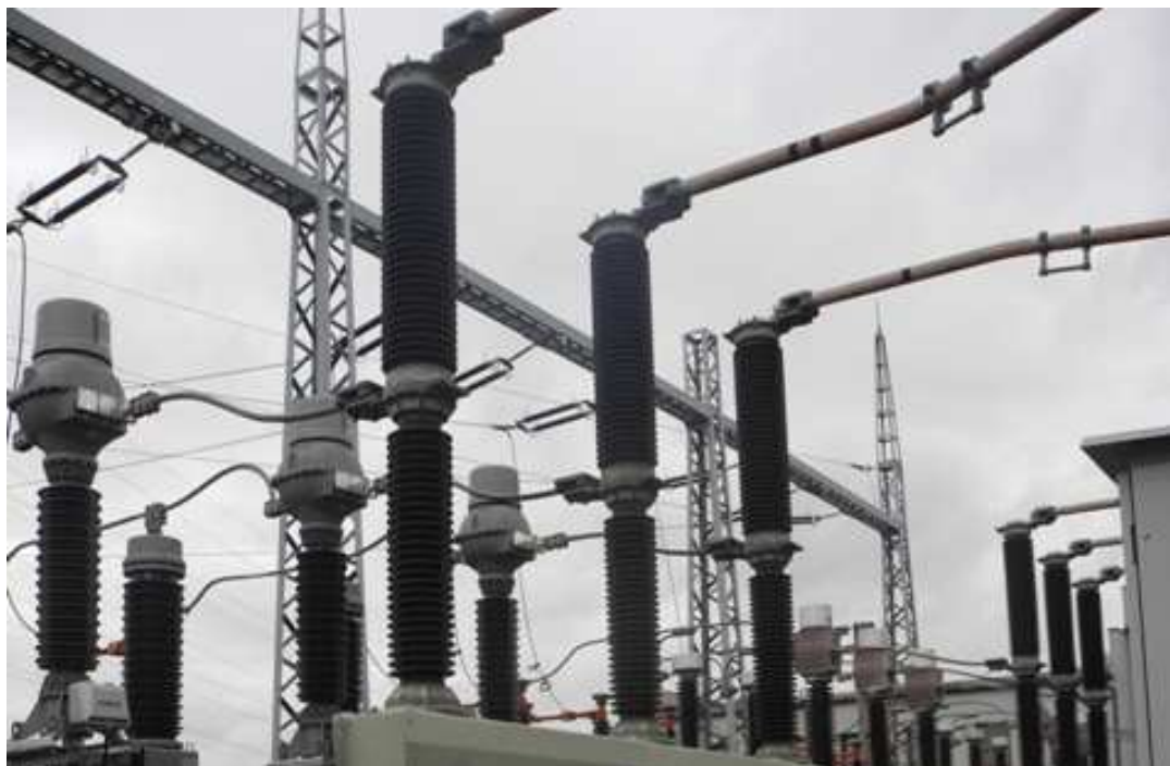
Obrázek 22: Vypínač VVN - RS Škoda
