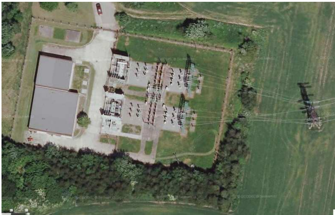
Obrázek 31: Letecký snímek rozvodny Křtěňov
