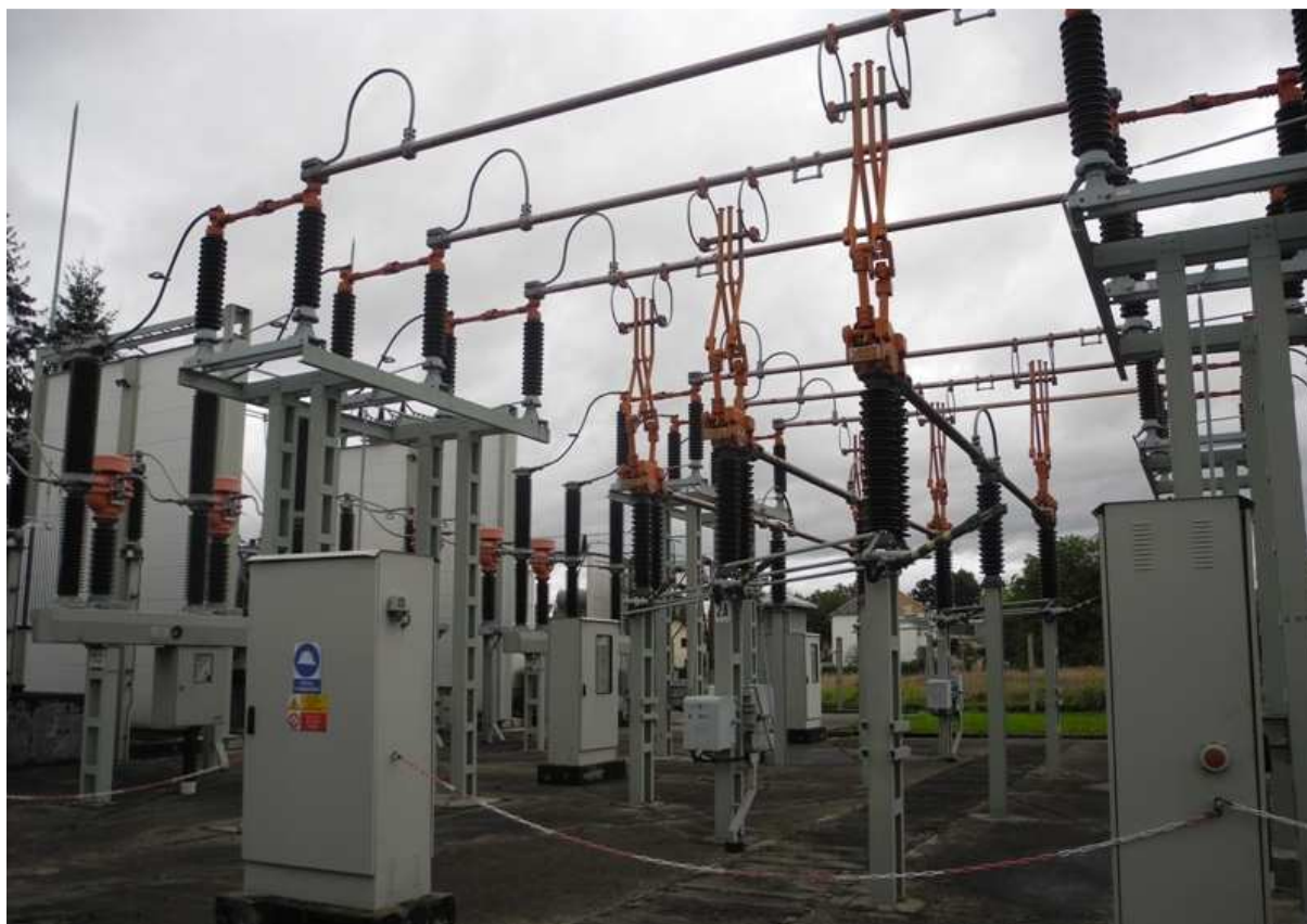
Obrázek 50: RS Mladé vybavena pantografickými odpojovači
