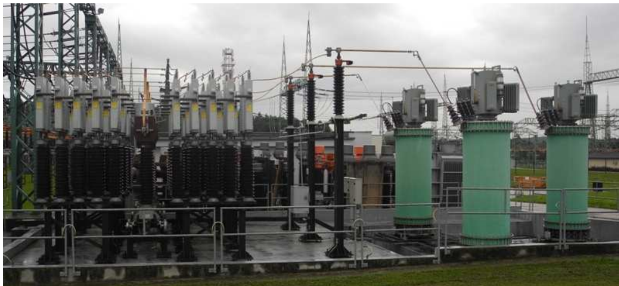
Obrázek 37: RS Dasný - zařízení hromadného dálkového ovládní (HDO)
