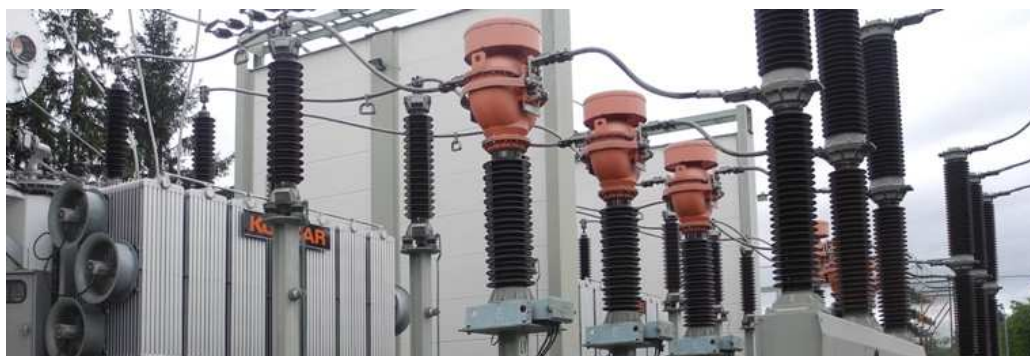
Obrázek 25: Kombinovaný transformátor proudu a napětí - RS Mladé
