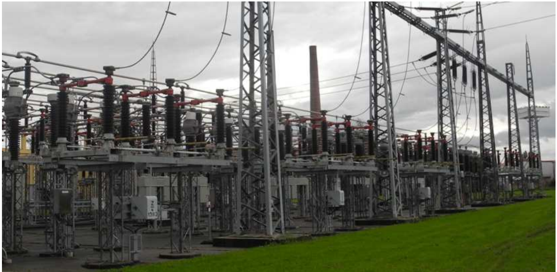
Obrázek 20: Vývodové odpojovače RS Škoda
