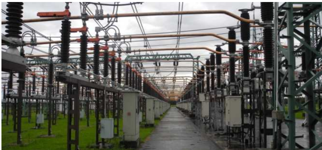
Obrázek 19: Přípojnicové pole - Dasný
