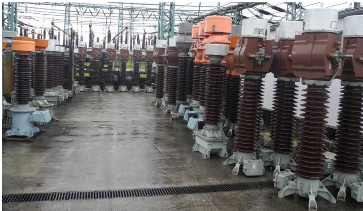
Obrázek 41: Větší množství vyřazených měřících transformátorů (Dasný)
