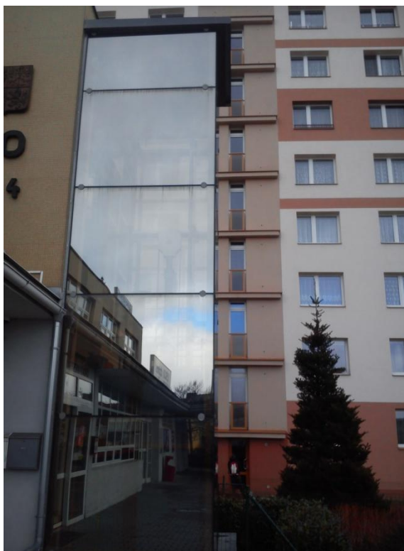
Obr. 1 Reflexní plocha výtahové šachty (Zdroj: (7))
