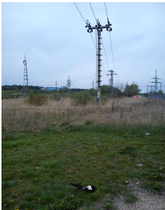
Obr. 4 Smrtelná srážka s elektrickým vedením (zdroj: (7))
