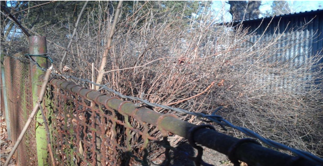
Obr. 6 Nevhodně vedený ostnatý drát (Zdroj: (7))
