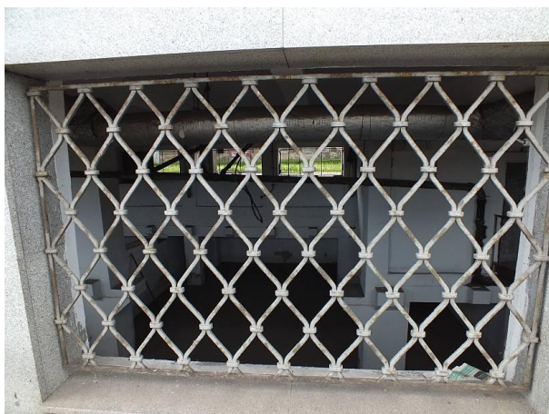
Obr. 10 Sklepní prostory (Zdroj: (3))
