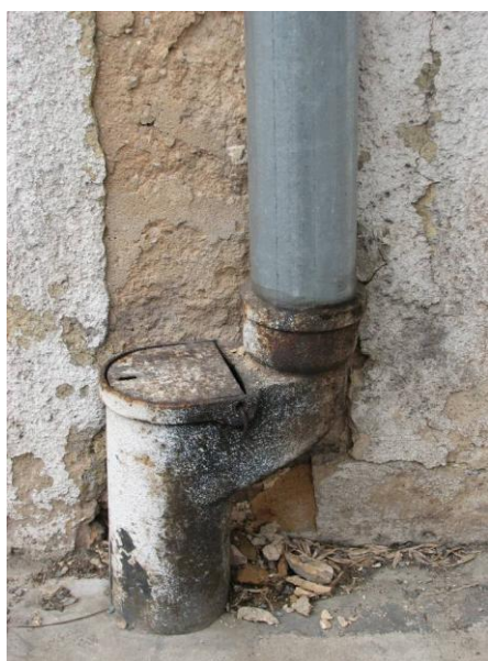
Obr. 12 nevhodné provedení okapu (Zdroj: (16))
