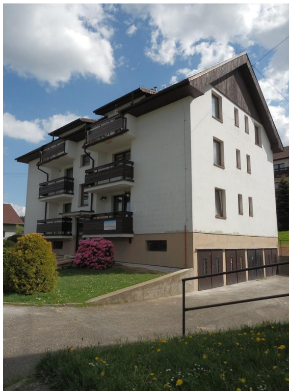
Obrázek 12: Pohled na bytový dům, pro nějž se navrhuje KJ
