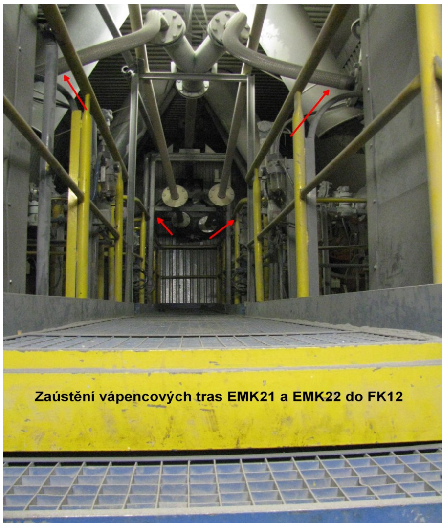
Obr. 4.3 Zaústění tras vápence do klínu kotle FK12
