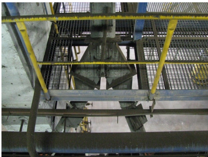
Obr. 4.9 Ruční rozdělovací klapka
