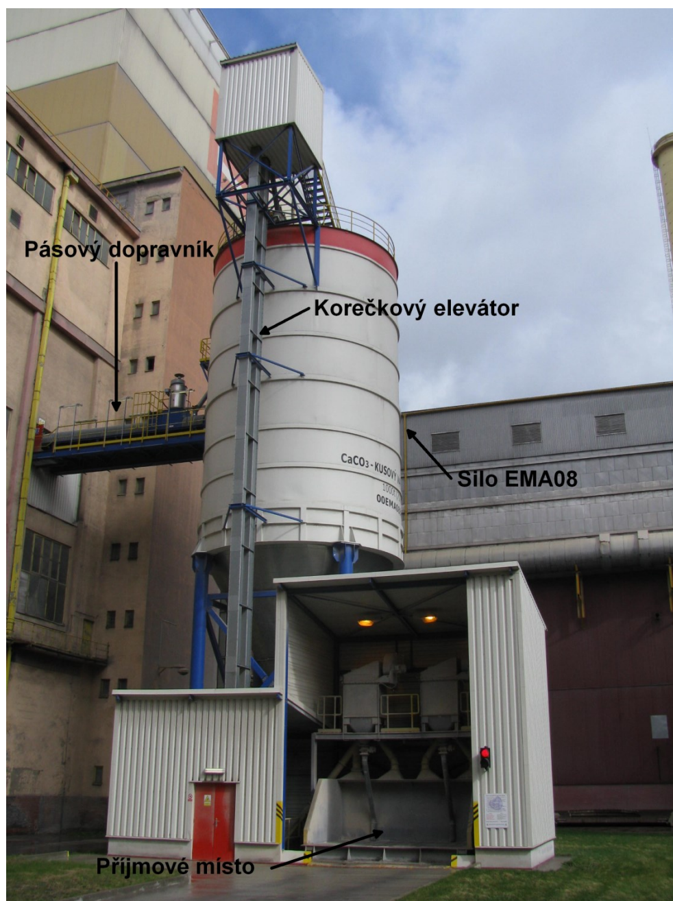
Obr. 4.7 Silo pro skladování hrubozrnného vápence pro FK12
