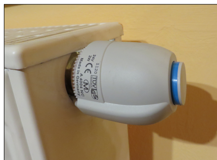
Obrázek 26 - Instalovaná termohlavice IVAR.TE 3041 v plně otevřeném stavu
