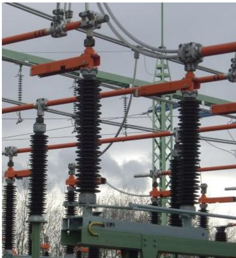
Obrázek 3.1 – Horizontální odpojovač 3SHJ-12xx
