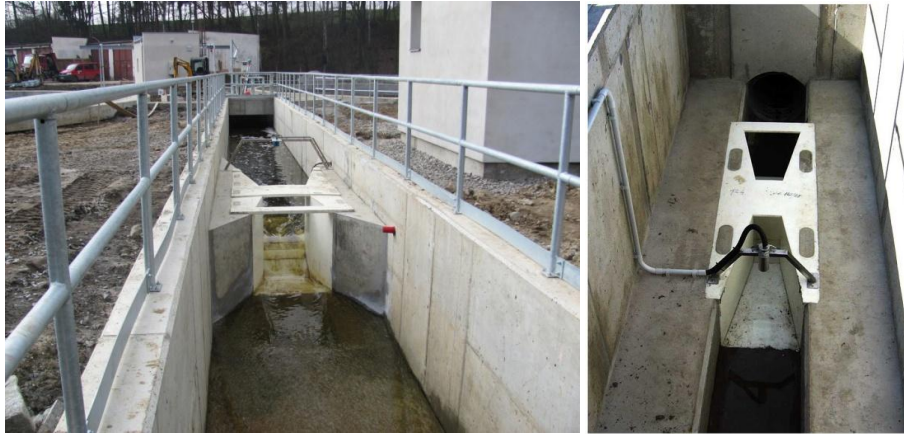
Obr. 2. 8 – Aplikace Parshallova žlabu [25]
