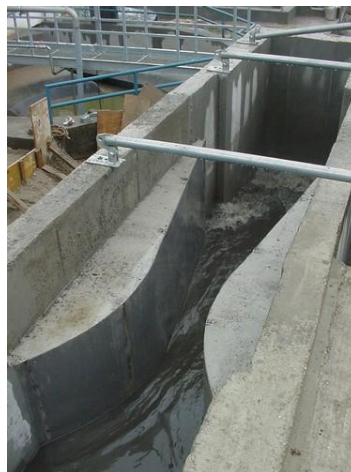
Obr. 2. 9 – Venturiho žlab v ČOV [25]
