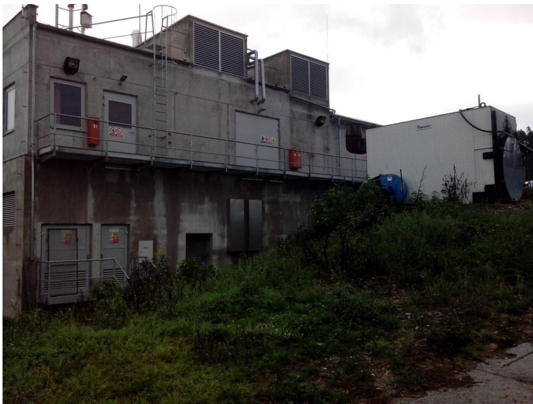
Příloha č. 3: Pohled na strojovnu
