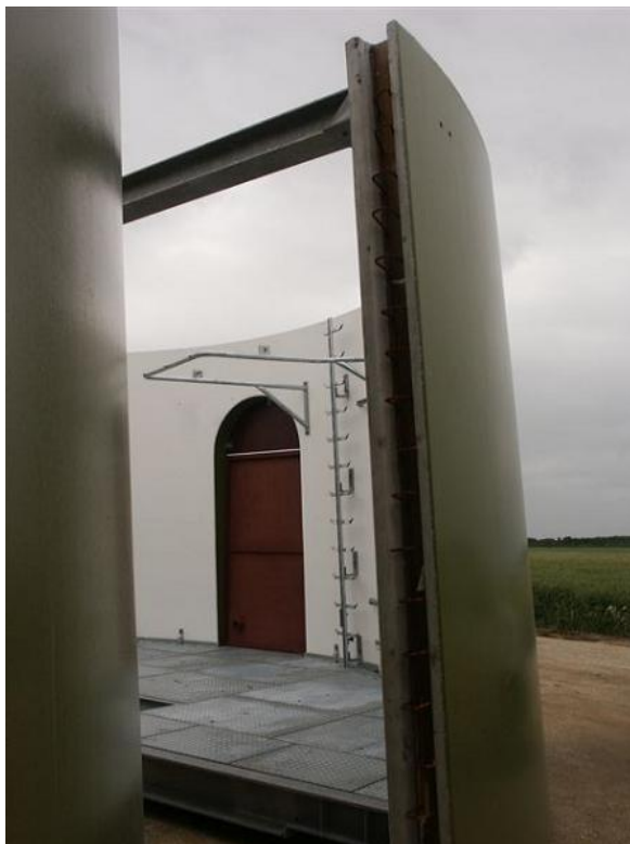
Obr. 3.2 Prefabrikovaný betonový stožár – spodní díl pro vstup do elektrárny
