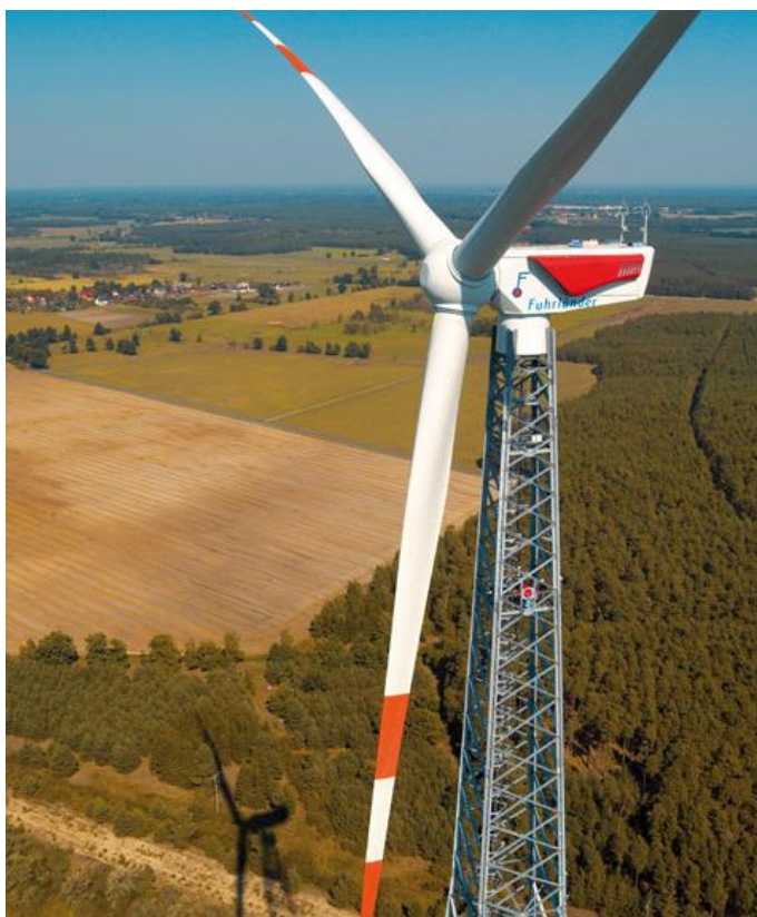
Obr. 3.1 Příhradový stožár větrné elektrárny [2]
