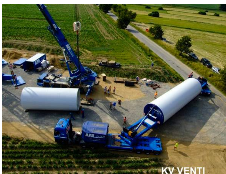
Obr. 3 Ocelové tubusy při převozu [6]
