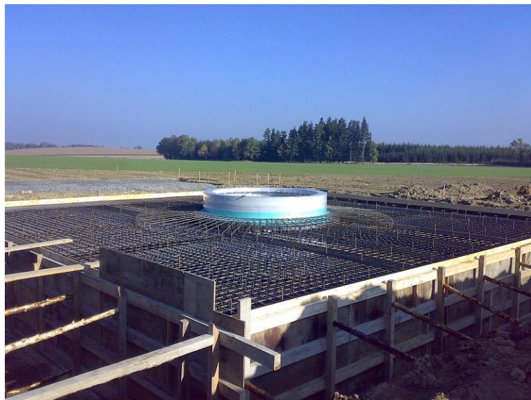
Obr. 3.8 Hotové armovací výztuže s bedněním [2]
