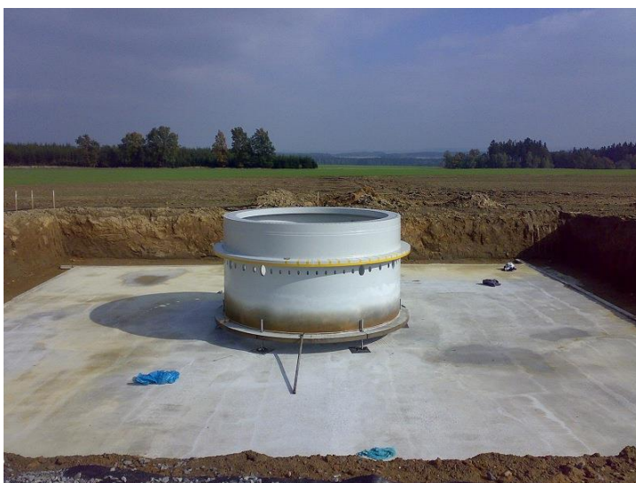
Obr. 3.7 Základová deska s usazeným ocelovým fundamentem na distančních šroubech [2]
