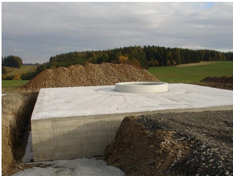
Obr. 3.9 Hotový železobetonový základ [2]
