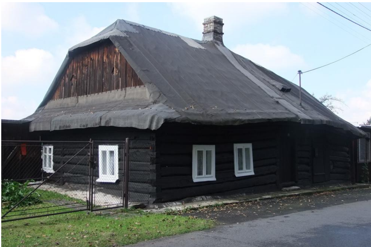
Obr. 8 Dům s podlomením a polovalbovou střechou v obci Raškovice (okr. Frýdek-Místek). Foto V. Petrová, 2013
