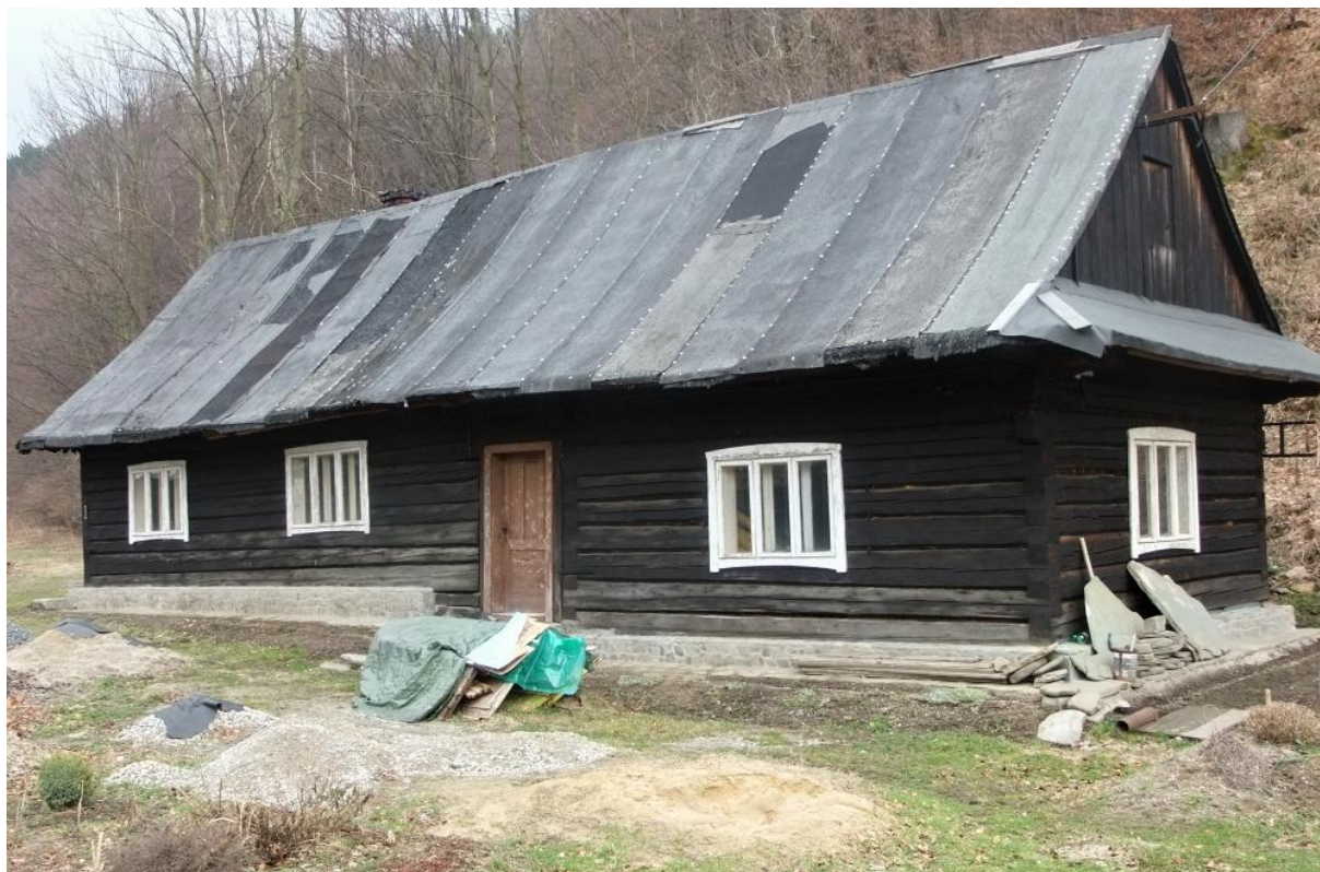
Obr. 12 Dům č. 150 v obci Dolní Bečva (okr. Vsetín). Foto V. Petrová, 2013
