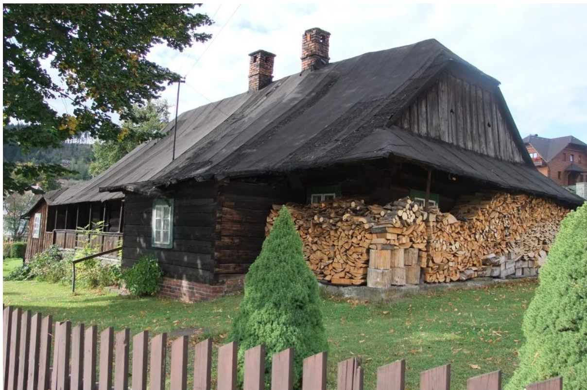
Obr. 6 Dům s podlomením a pavlačovým zápražím v obci Nýdek (okr. Frýdek-Místek) . Foto V. Petrová, 2013
