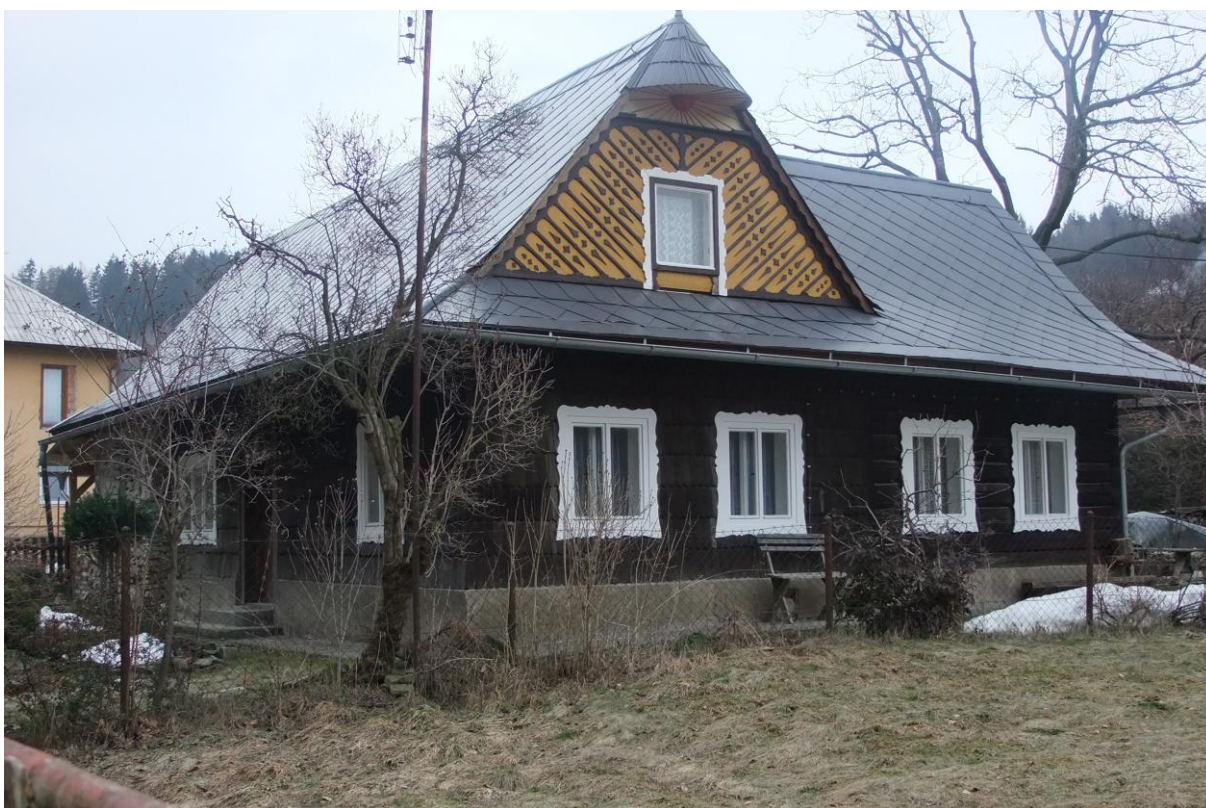
Obr. 11 Dům v Rožnově pod Radhoštěm s podlomením, kabřincem a lomenicí s malbou (okr. Vsetín). Foto V. Petrová, 2013
