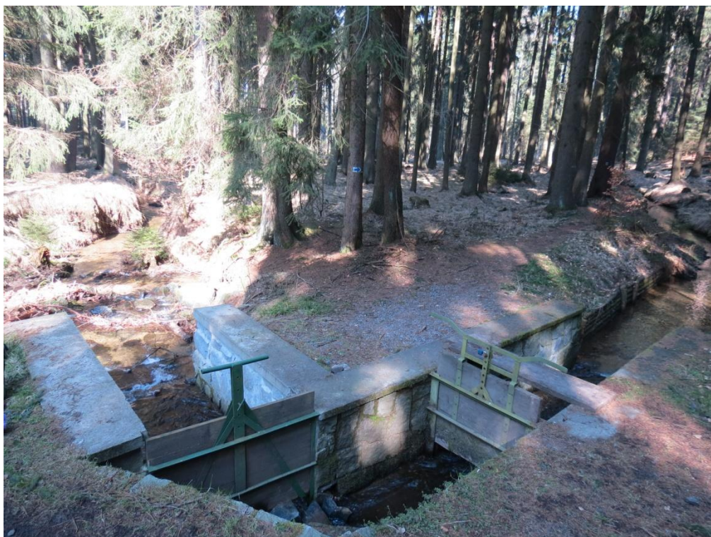
Obr. XIX – Pohled na rozdělovací objekt, Bystřice (vpravo), náhon Teplé Bystřice (vlevo)
