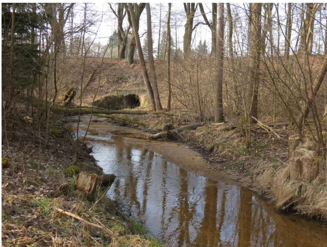
Obr. XXV – Pohled na Bystřici před zaústěním do rybníku Babylon
