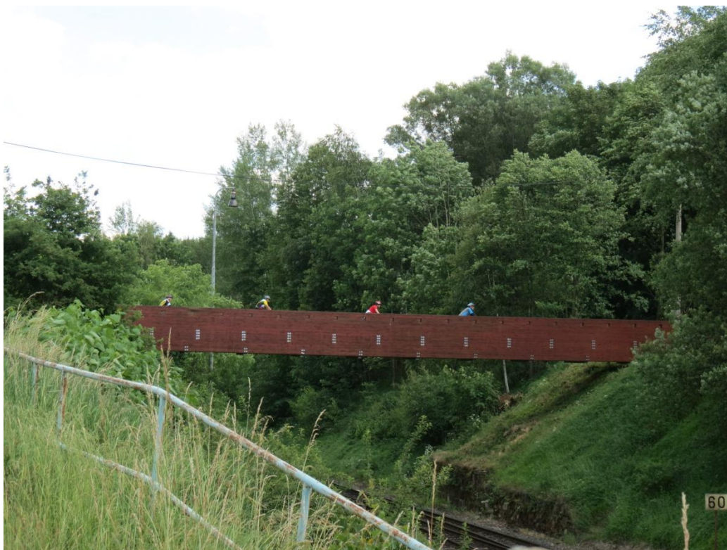
Obr. IX – Pohled na nový dřevěný akvadukt na Hadrovci
