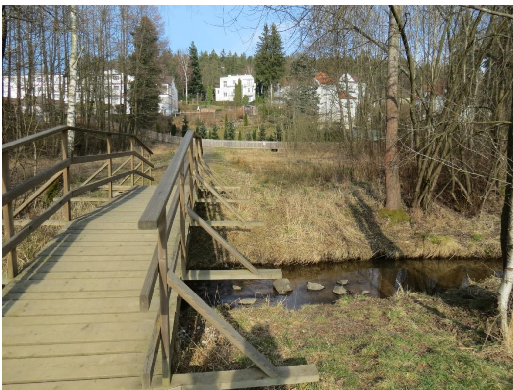
Obr. XXIV – Pohled na protékání Bystřice kolem zástavby Babylonu
