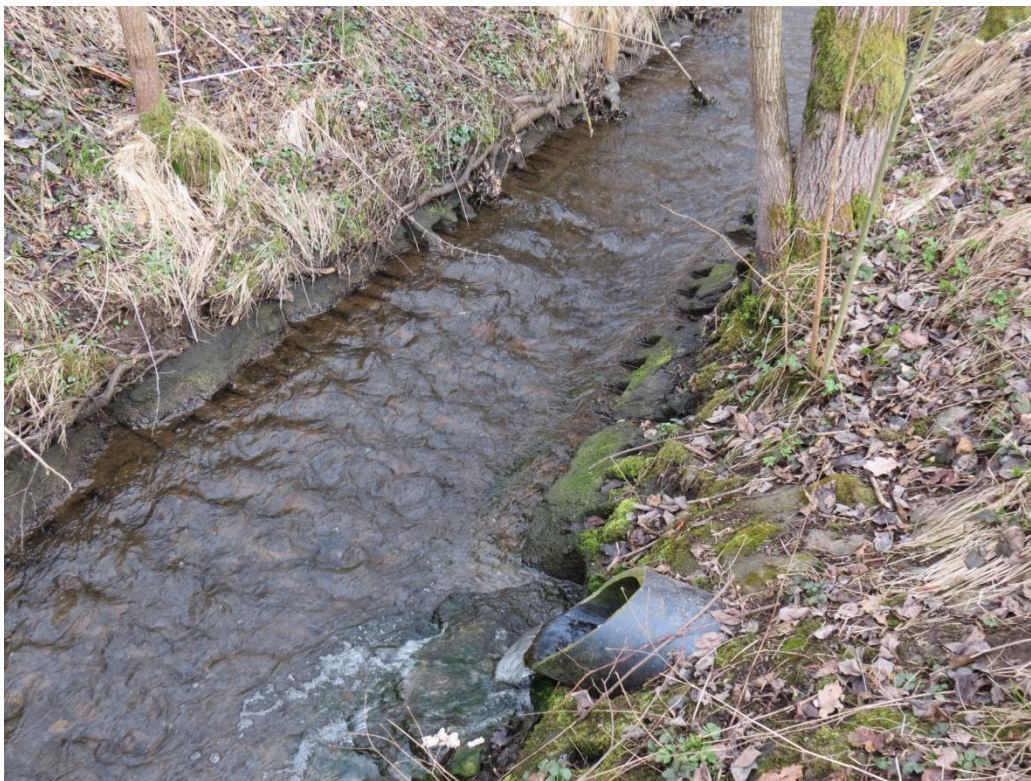
Obr. XXXVII – Pohled na napřímený úsek Teplé Bystřice v místě vyústění vod z ČOV
