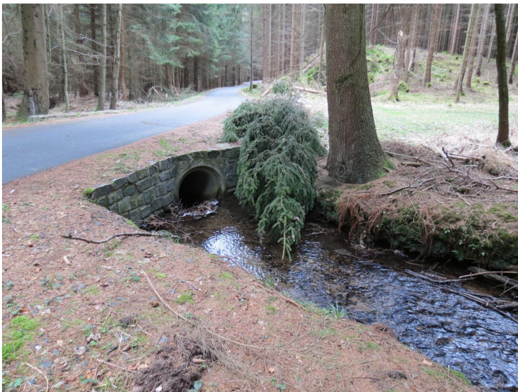
Obr. XXXIV – Pohled na Teplou Bystřici při podtékání lesní cesty
