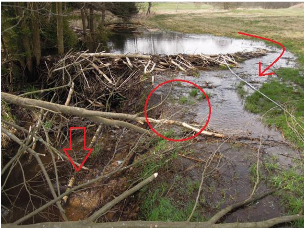
Obr. 51: Bobří hráze a obtékání vody přes zemědělskou půdu 1, 4. 4. 2014
