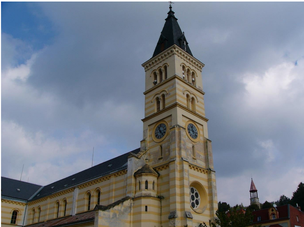
Kostel Božího těla v Kraslicích
