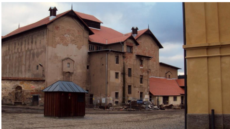
Obr. 25. Ležácké sklepy, současný stav, probíhající stavební práce (leden 2015). Zdroj: archiv autora.
