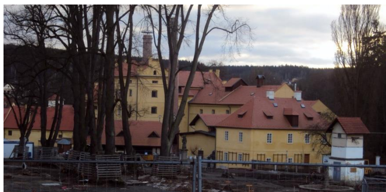
Obr. 27, 28 a 29. Současný stav areálu CSD, probíhající stavební práce (leden 2015). Zdroj: archiv autora.
