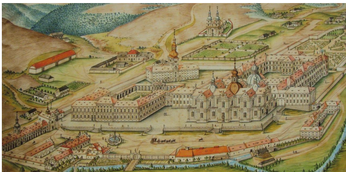
Obr. 3. Celkový pohled na plaský klášter, veduta z konce 18. století. Zachycuje ideální podobu nerealizovaného Santiniho projektu (s tříkopulovým kostelem). Zdroj: ŠORM, Martin. Bazilika Nanebevzetí Panny Marie v Plasích (nestránkováno).
