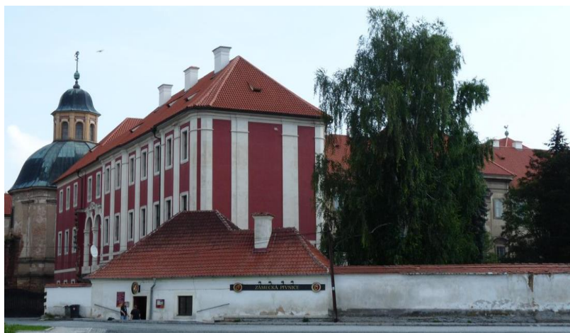
Obr. 7. Pohled na nemocniční křídlo konventu plaského kláštera, současný stav (červen 2014). Zdroj: archiv autora.
