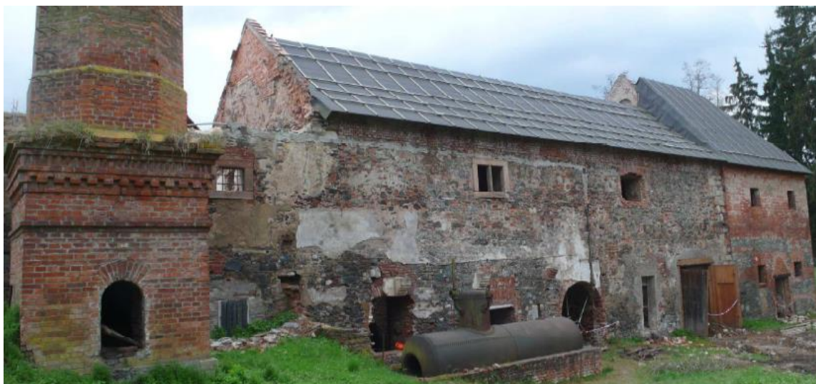
Obr. 31. Rekonstrukce hospodářského dvora. Lihovar - objekt „B“ (2014).
