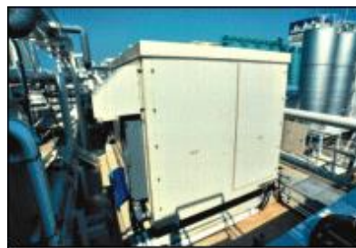
Obrázek 17 Modul s palivovým článkem v Ashai o výkonu 200kW [6].
