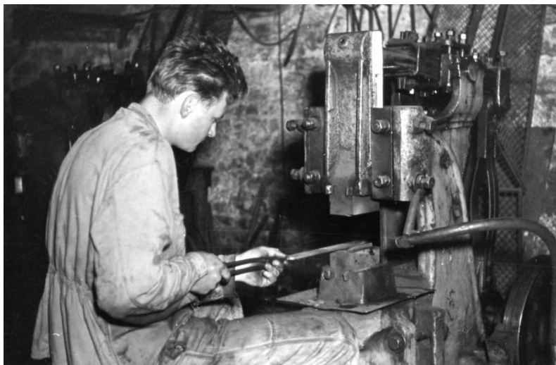
Obr. 9 - Ukázka kování s použitím kovářských kleští [5]
