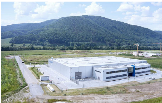
Obr. 1-5 firma Burgmaier v Baňské Bystrici [1]
