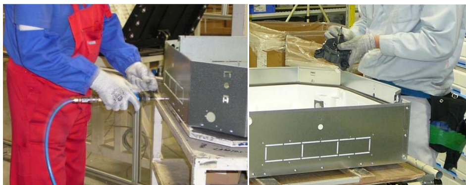
Obrázek 3.4: Obrázek vlevo: Přišroubování bočních plechů k základně na pracovišti DP 2015-1;
