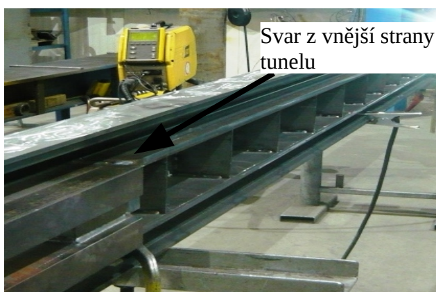
Obrázek 3.29: Zavaření na boku "tunelu"
