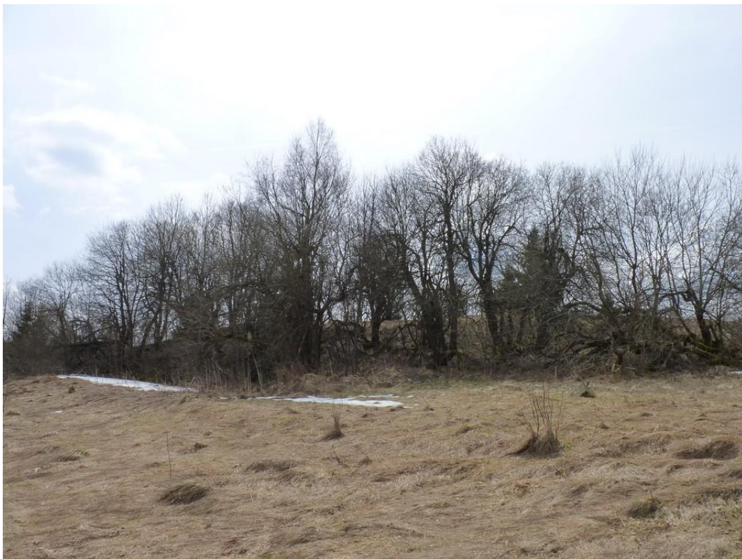
Obr. 63: Pohled od východu na sutiny kostela.
