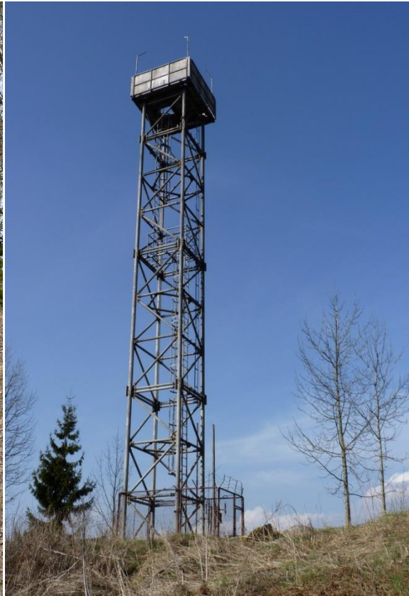
Obr. 62: Bývalá pozorovací hláska.
