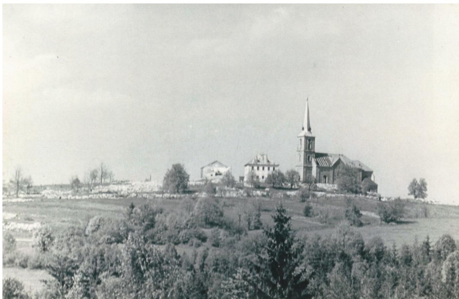
Obr. 40: Celkový pohled na kostel s farou v průběhu demolice.
