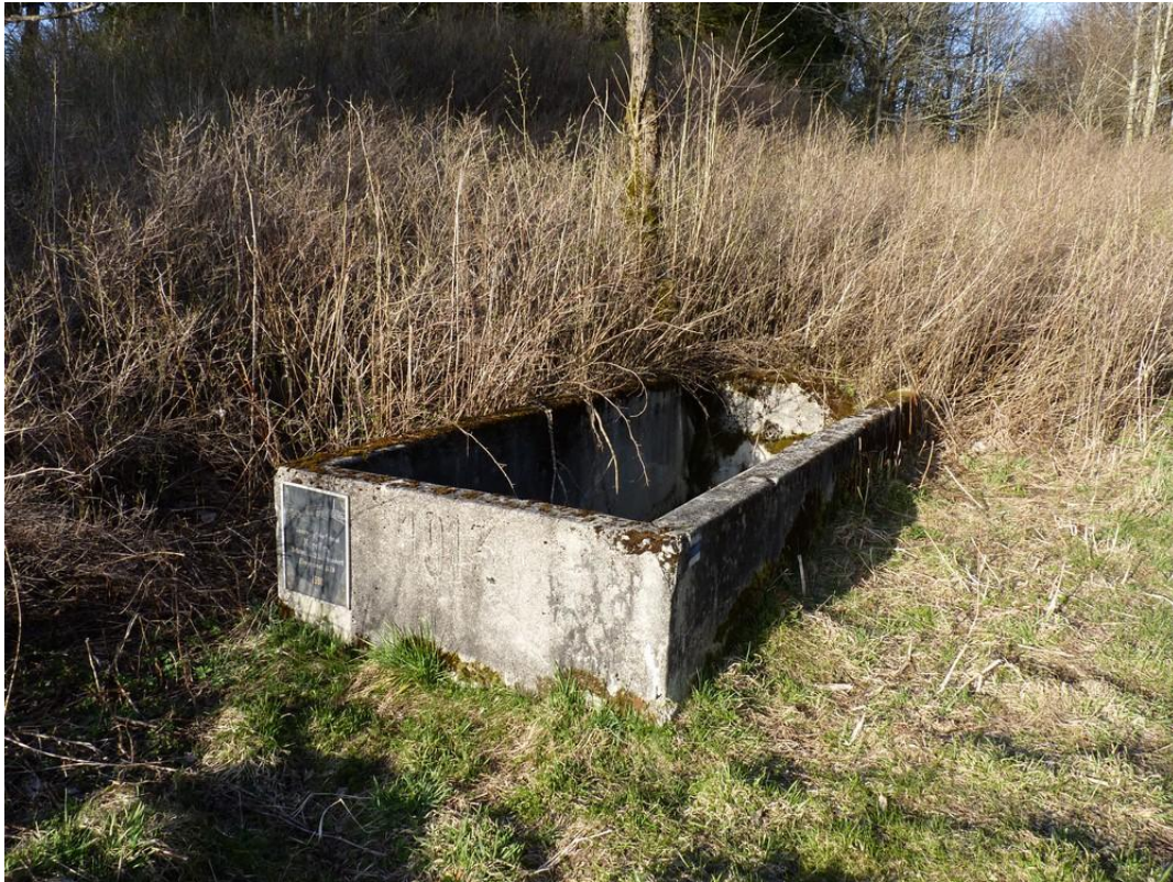
Obr. 76: Nádrž na vodu.
