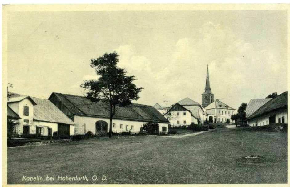
Obr. 45: Pohlednice z roku 1918.
