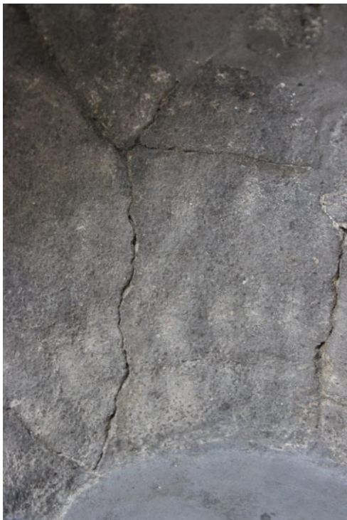
Obr. 9 Stopy po prstech při zahlazování válků (IČ 2811; foto autorka)
