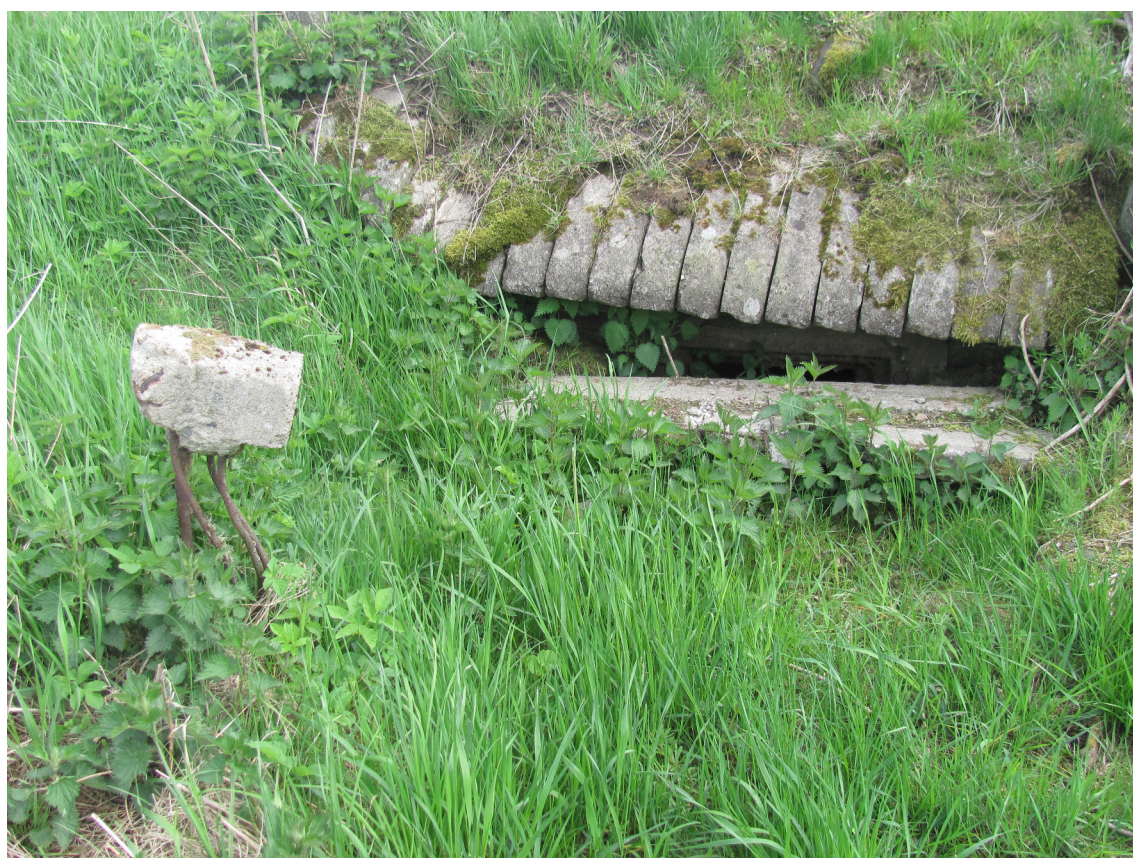
Obr. 21 - Palebný objekt KŽ-1 (PS-B-L-05). Detail střílny, zřetelně jsou vidět „kobyly hlavy“. (foto B. Nejedlá)
