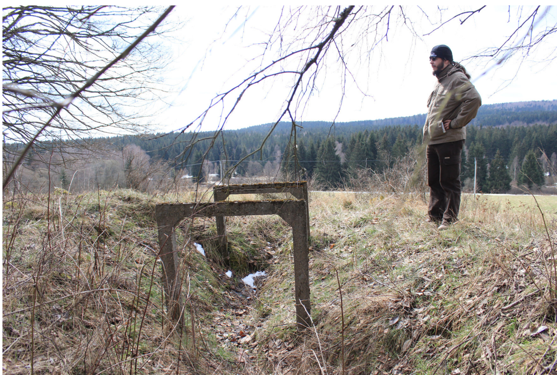
Obr. 59 – Železobetonové prefabrikované dílce (H-B-02). Součást zákopového systému (H-Z-01). (foto J. Čibera)
