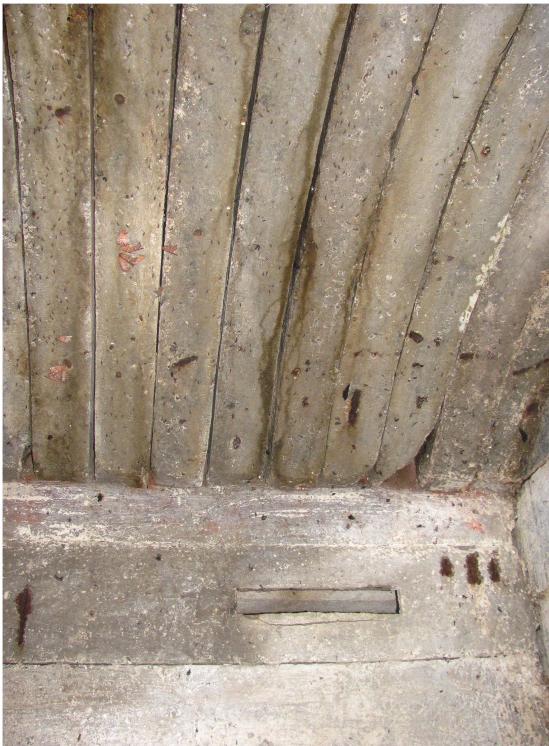
Obr. 17 - Palebný objekt KŽ-1 (PS-B-L-03). Dobře viditelný průzor a „kobyli hlavy“ tvořící strop objektu.
