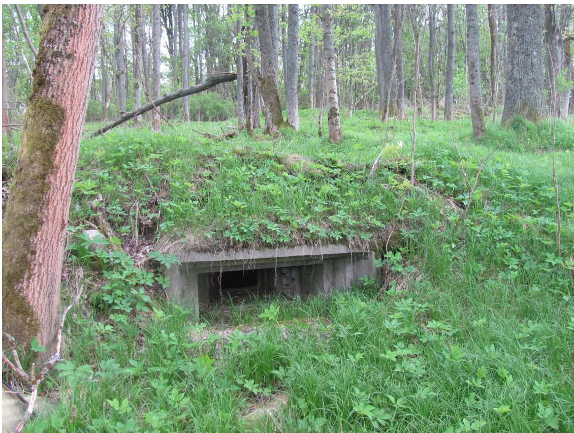
Obr. 39 – Jedná se o palebný objekt KŽ-1 (S-B-P-01), který je zasazen do zarostlé destrukce domu (nedaleko zadní stěny je i propadlý sklep) na katastru zaniklé obce Jedlina. Pohled od severozápadu. (foto B. Nejedlá)
