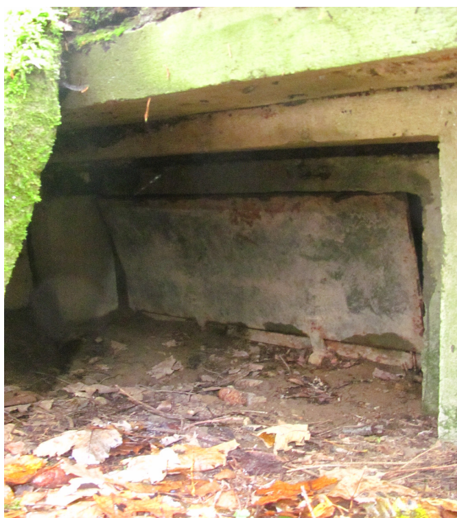
Obr. 19. - Palebný objekt KŽ-1 (PS-B-P-04). Detail záklopného ocelového krytu střílny. (foto B. Nejedlá)
