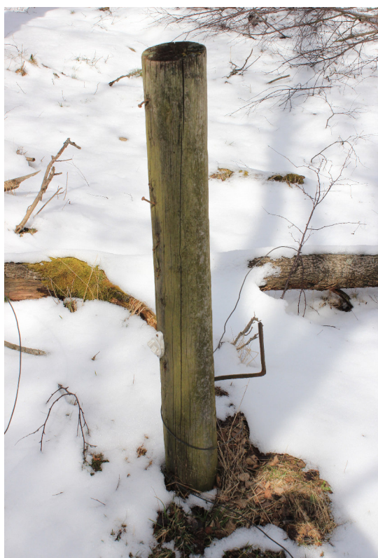
Obr. 84 – Druhotně použitý sloup z linie EZOH v úseku roty PS Pleš. Znatelný je hák na kterém byl původně umístěn elektrický izolátor. (foto J. Čibera)
