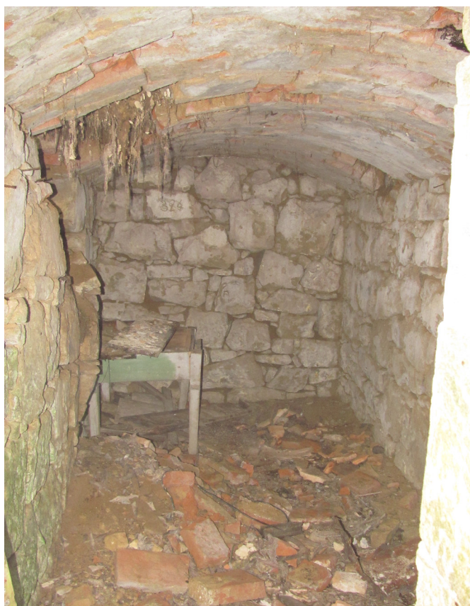
Obr. 57 - Pohled dovnitř sklepa (H-B-01).
