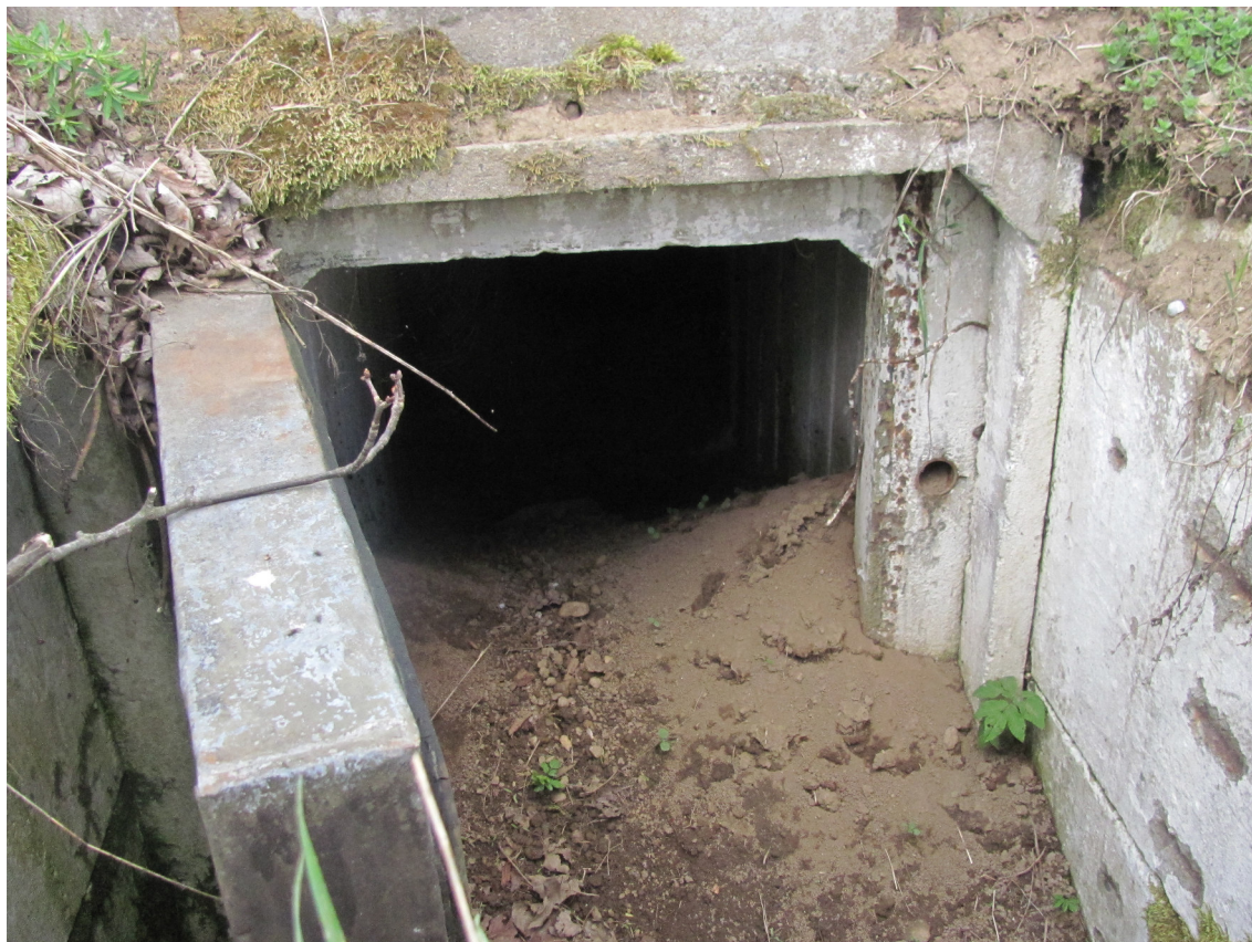
Obr. 24 - Palebný objekt KŽ-1 (PS-B-L-06). Detail šachtového vstupu. Jak je patrné, vstup je částečně zasypan. (foto B. Nejedlá)
