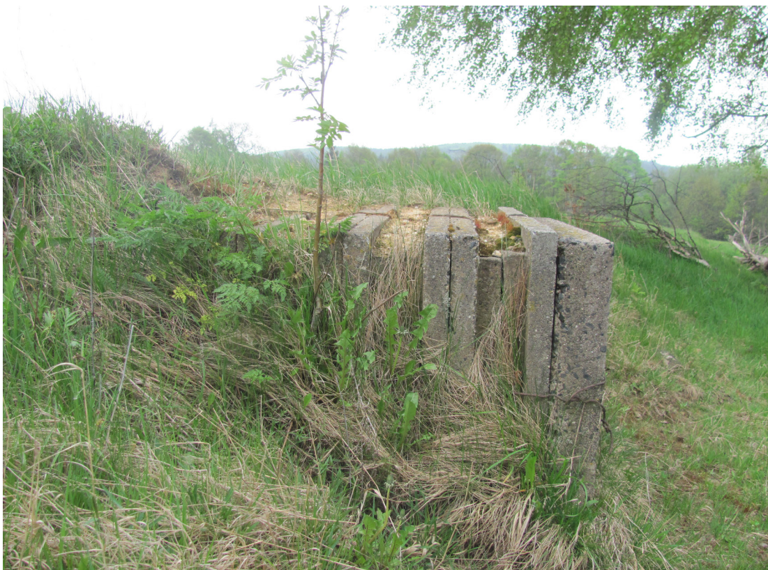
Obr. 43 - Pozorovatelna PŽ-2 (S-B-02) nad obcí Jedlina. Detail odhalených prefabrikovaných částí. (foto B. Nejedlá)
