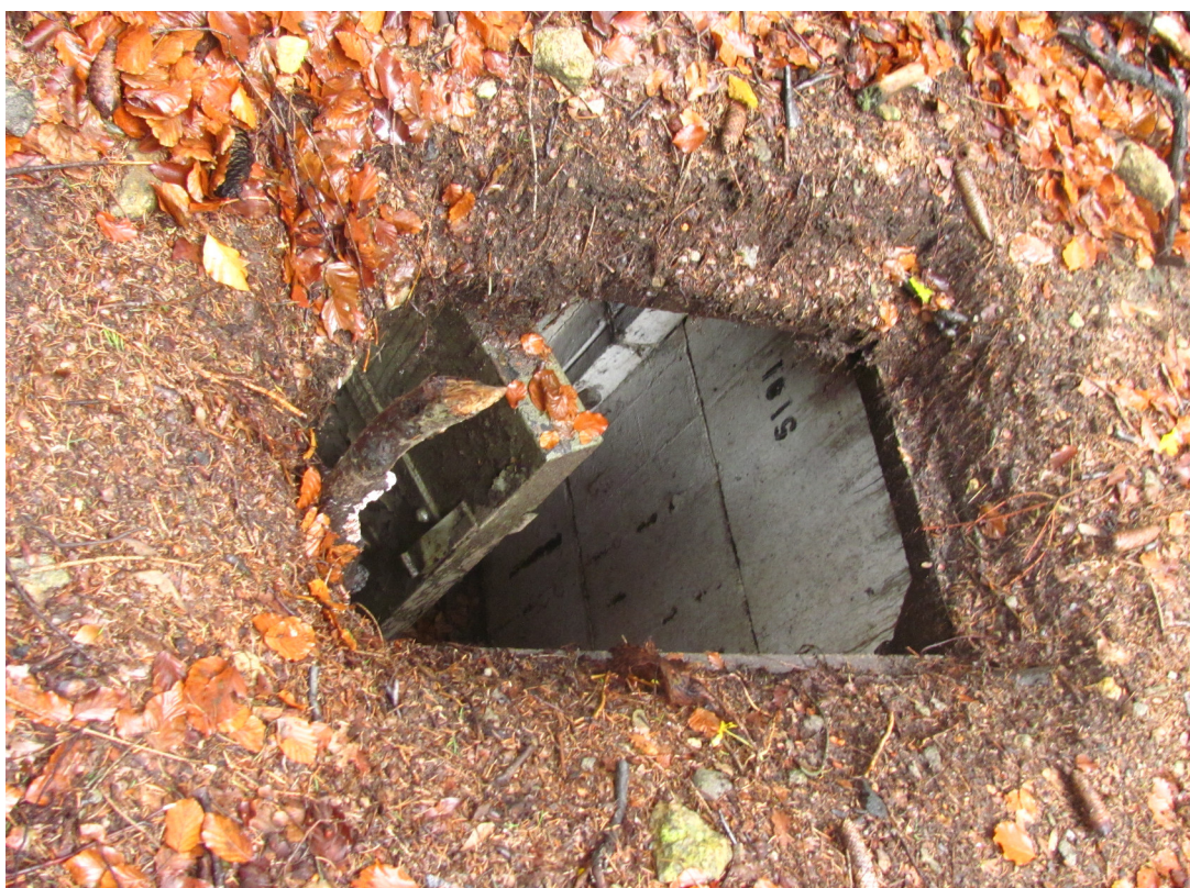
Obr. 16 - Palebný objekt KŽ-1 (PS-B-L-03). Pohled šachtovým vstupem do chodby. Na levé části fotografie jsou viditelné tlakové dveře. (foto B. Nejedlá)
