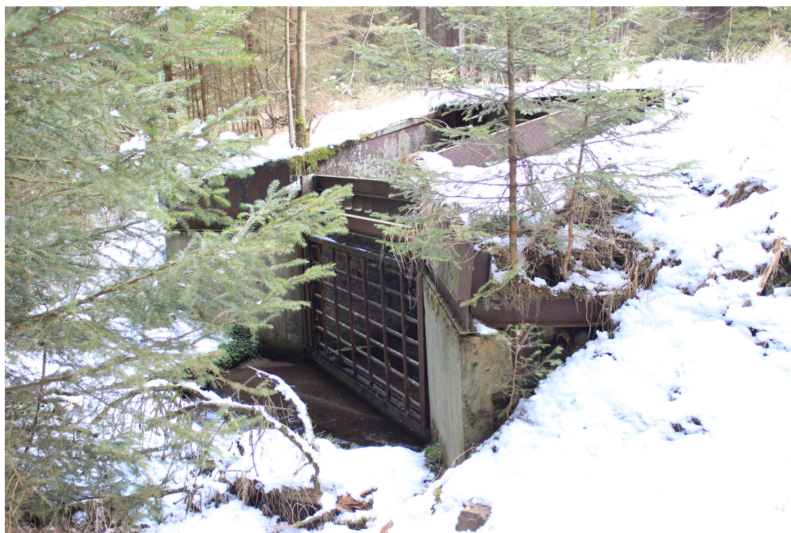
Obr. 28 – Vodní zábrana (PS-VZ-01). Pohled z boku. (foto J. Čibera)
