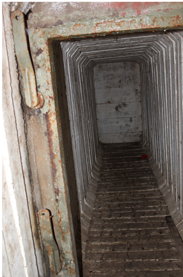
Obr. 75 – Vnitřek objektu KŽ-4 (PL-B-02).
