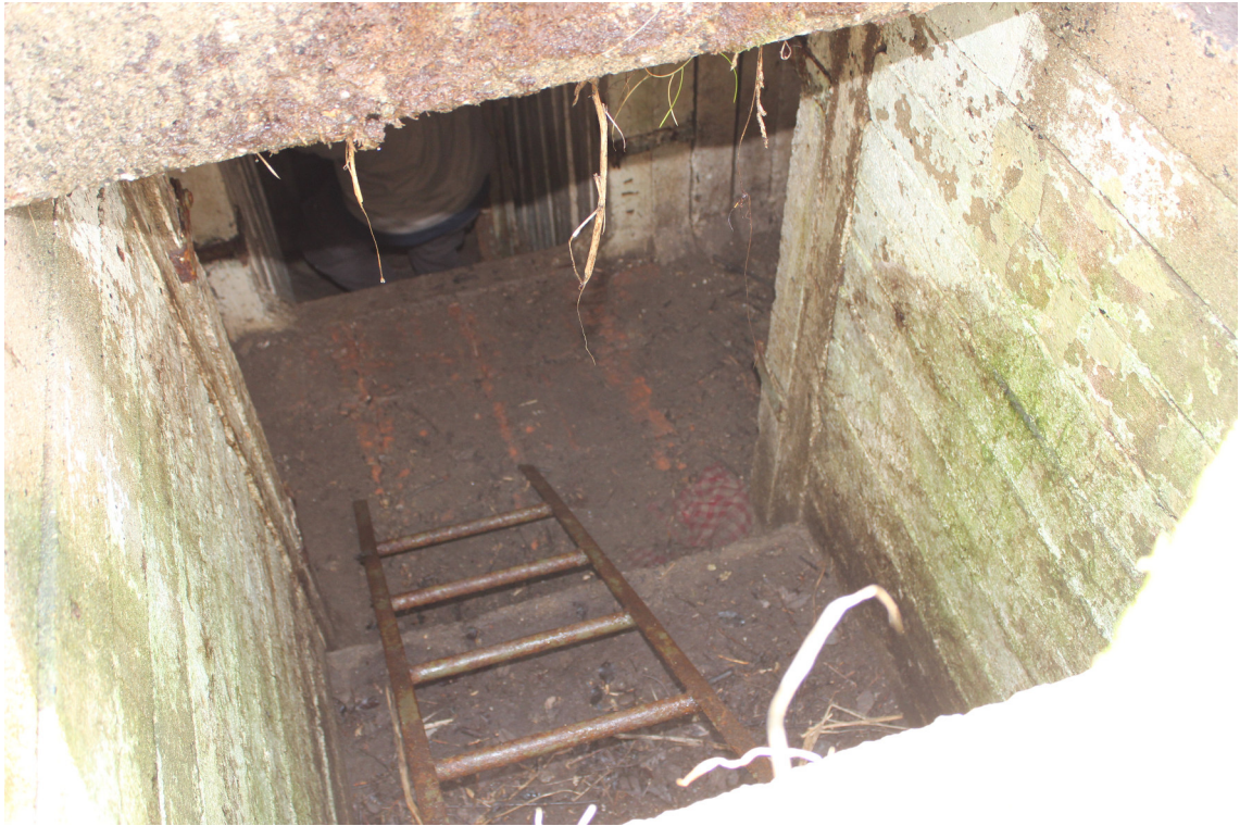
Obr. 74 – Šachtový vstup objektu KŽ-4 (PL-B-02). (foto J. Čibera)
