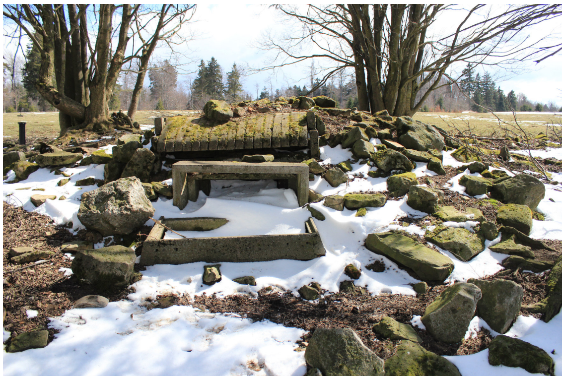
Obr. 13 – Palebný objekt KŽ-1 (PS-B-P-01) s rozvalenou střílnovou nástavbou a obnaženými „kobylymi hlavami“. Pohled od západu. (foto J. Čibera)
