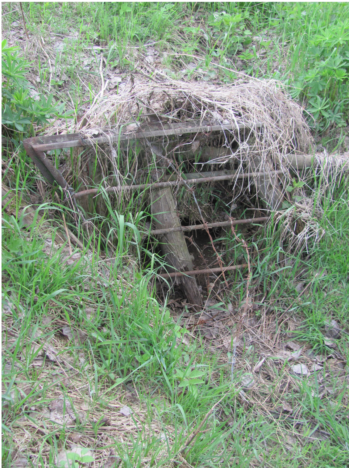
Obr. 31 – Vodní zábrana (PS-VZ-02) na jednom z přítoků sklářského potoka. (foto B. Nejedlá)
