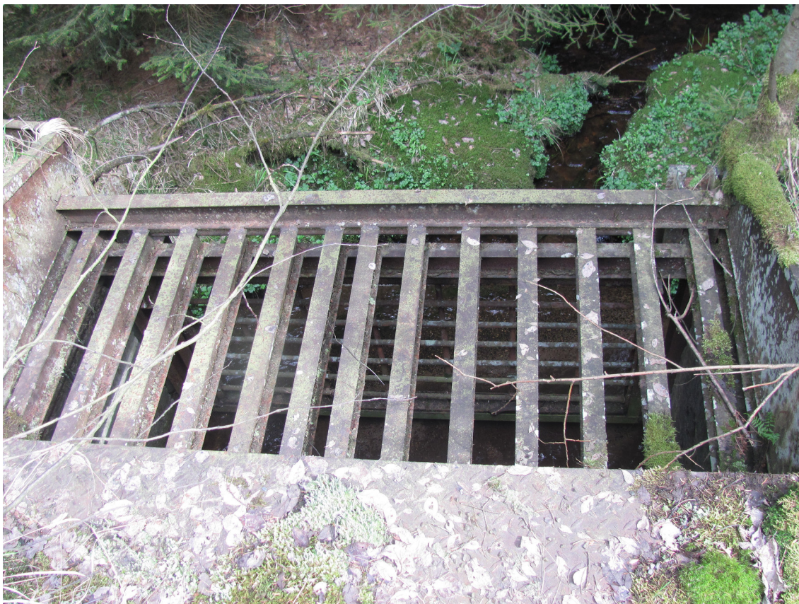
Obr. 29 - Vodní zábrana (PS-VZ-01). Pohled z vrchu. (foto B. Nejedlá)
