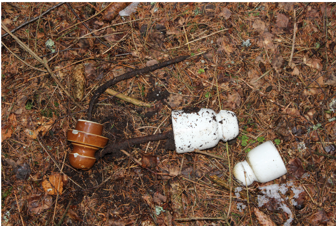
Obr. 63 – Elektrické izolátory na linii EZOH v úseku roty PS Hraničky. (foto J. Čibera)
