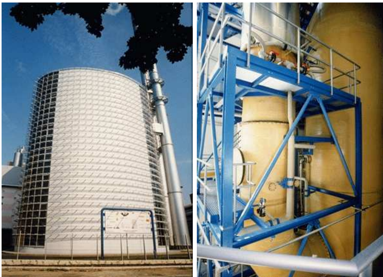
Obr. 24 Budova pračky spalin v Termizo Liberec a pohled na těleso pračky uvnitř [24o]
