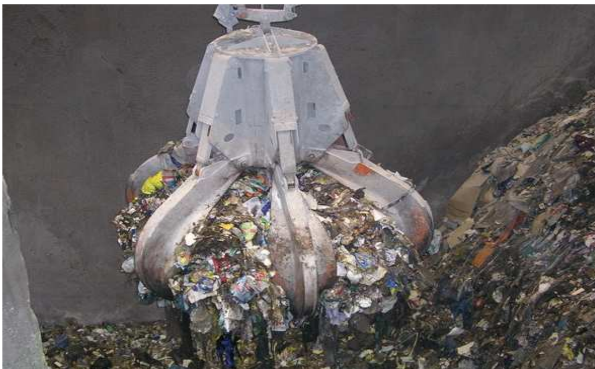
Obr. 25 Jeřáb nakládající odpady v Termizo Liberec [25o]
