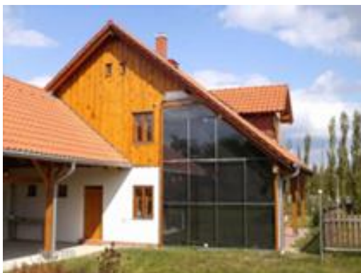
obr. 2.3: Realizovaná Trombeho stěna (Netunice, Plzeňský kraj) [3]
