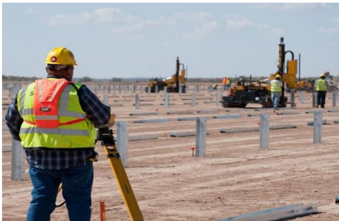
Obr. 17 Stavba solární elektrárny v pouštích Kalifornie, která by měla dosahovat výkonu až 1000 MW [18o]
