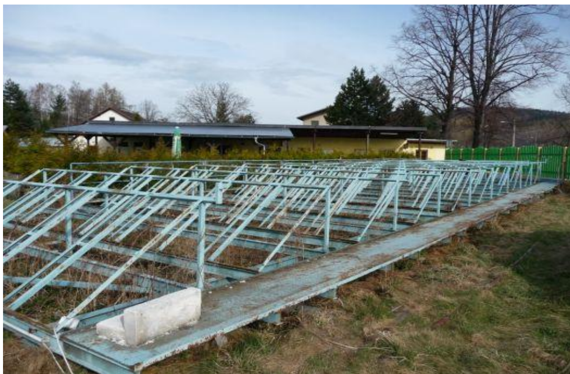
Obr. 24 Zbylá konstrukce po demontáži FV panelů [24o]
