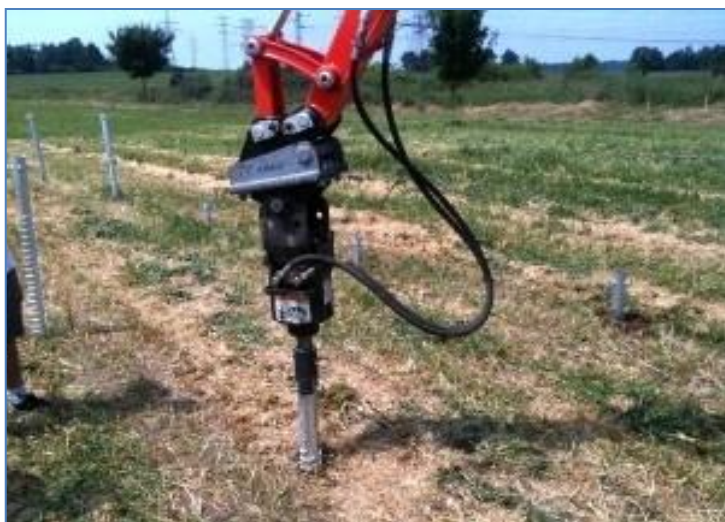
Obr. 8 Zakládání konstrukce vrtacím strojem nebo hlavicí na hydraulickém principu
