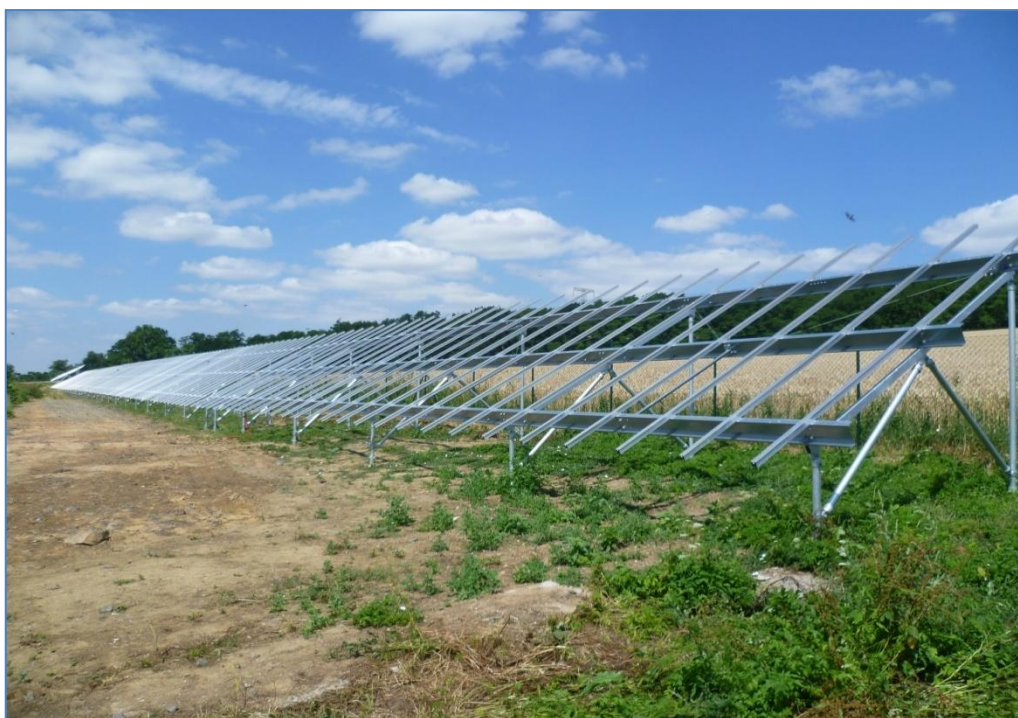
Obr. 9 Konstrukce připravená na osazení panely
