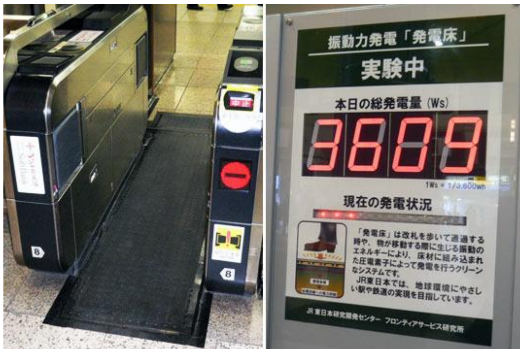
Obrázek 2.4-2.3.2-1 Podložka mezi turnikety a informační displej [12]
