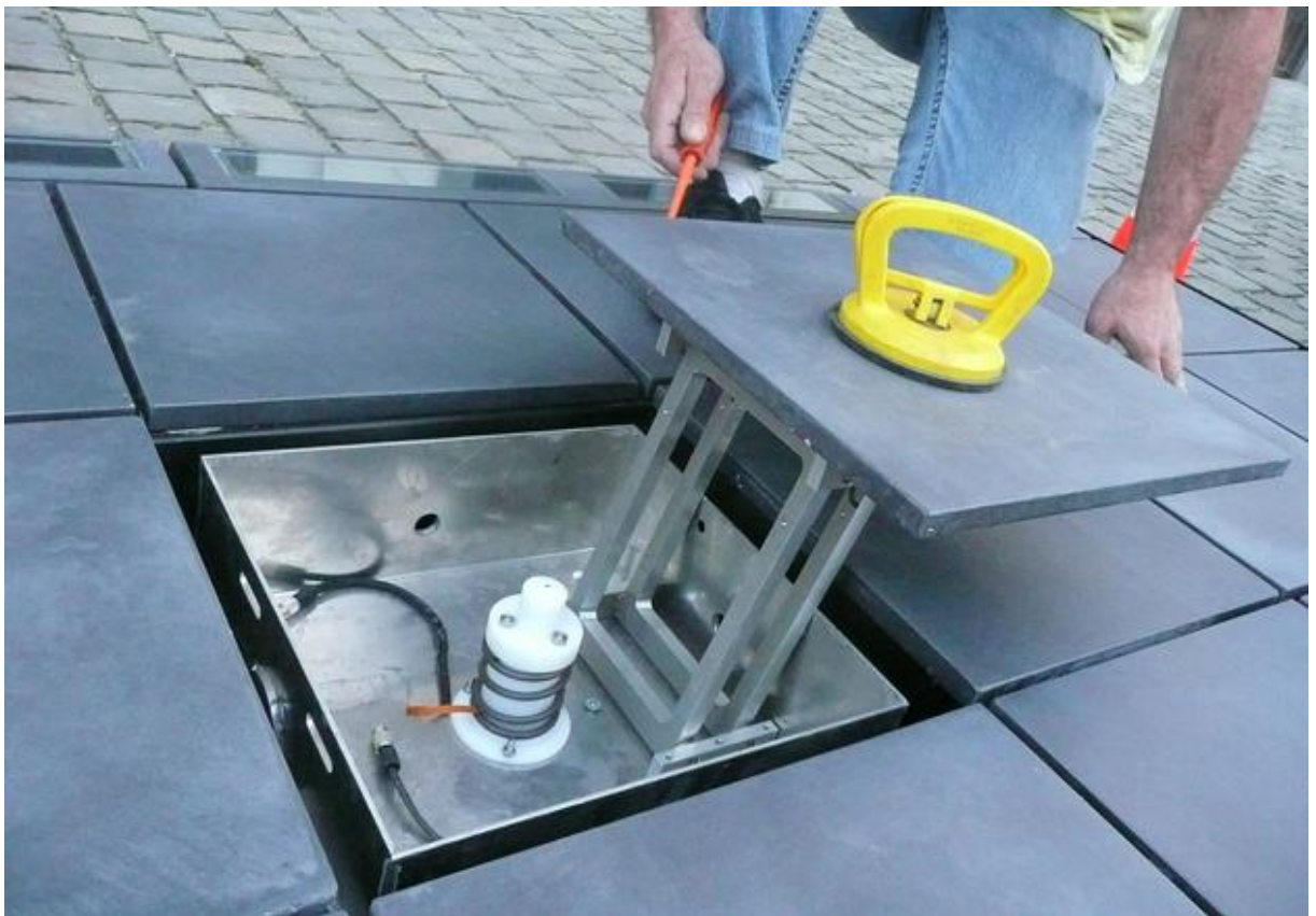
Obrázek 2.6-2.3.2-1 Ukázka SDF systému v chodníku v Toulouse [20]
