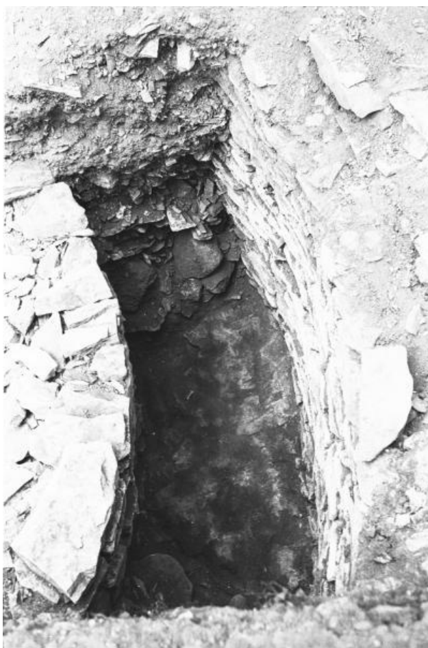
Obr. 16: Prostor mezi opukovými zdmi v objektu cisterny hrad Žampach (dle Cejpová 2007, http://www.uspza.cz/obrazky4/archeolog.pruzkum_08_big.jpg ).
