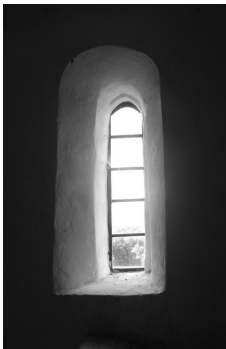
Obr. 11. Detail románského okenního otvoru
