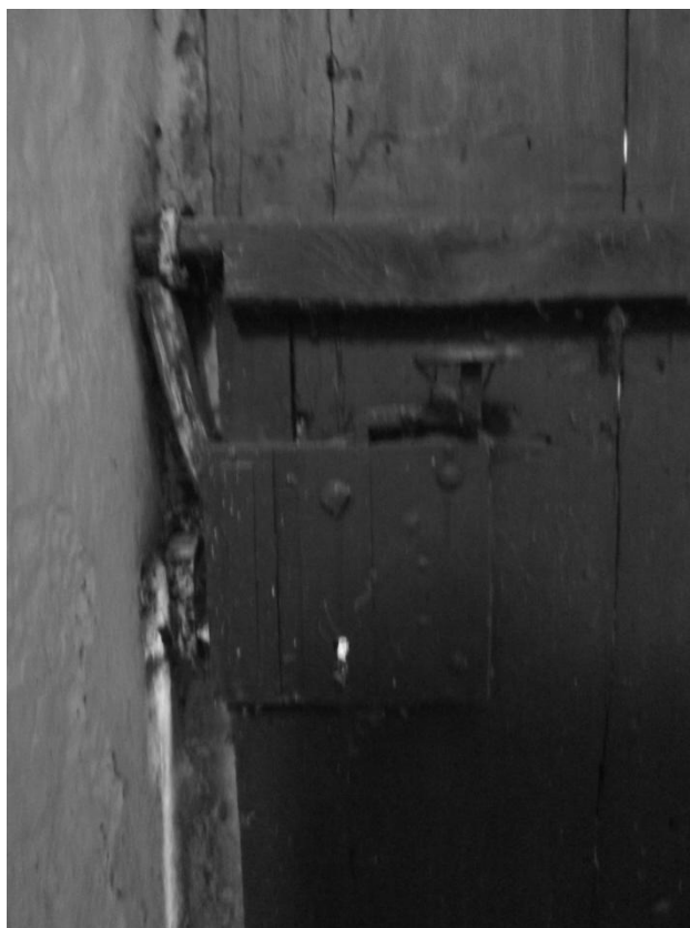
Obr. 10. Pravá hloubková zeď, zámek krabicového typu
