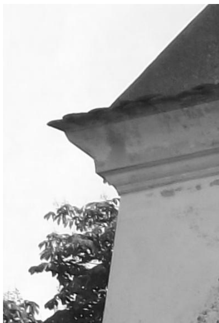
Obr. 2. Detail okapní římsy
