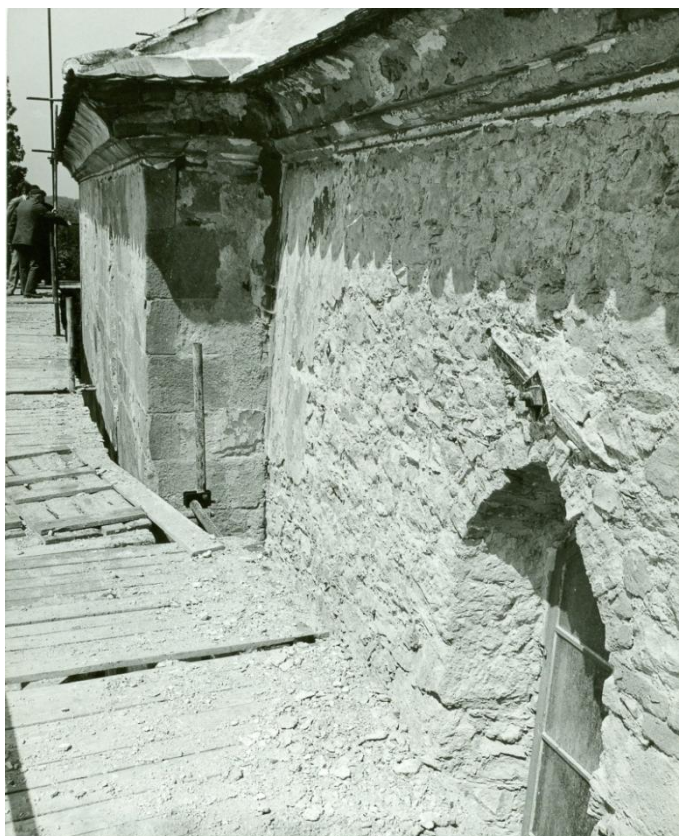
Obr. 29. Detail režného zdiva z roku 1987(převzato z: NPU Plzeň)
