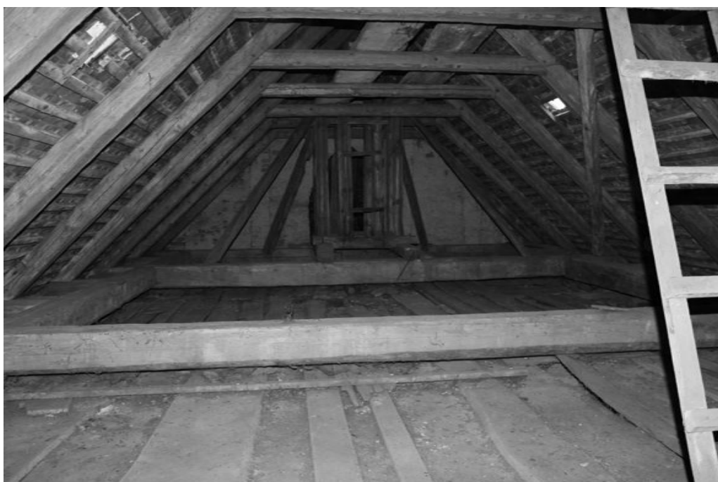
Obr. 22. Pohled na hambalkový krov, konstrukce sanktusníku
