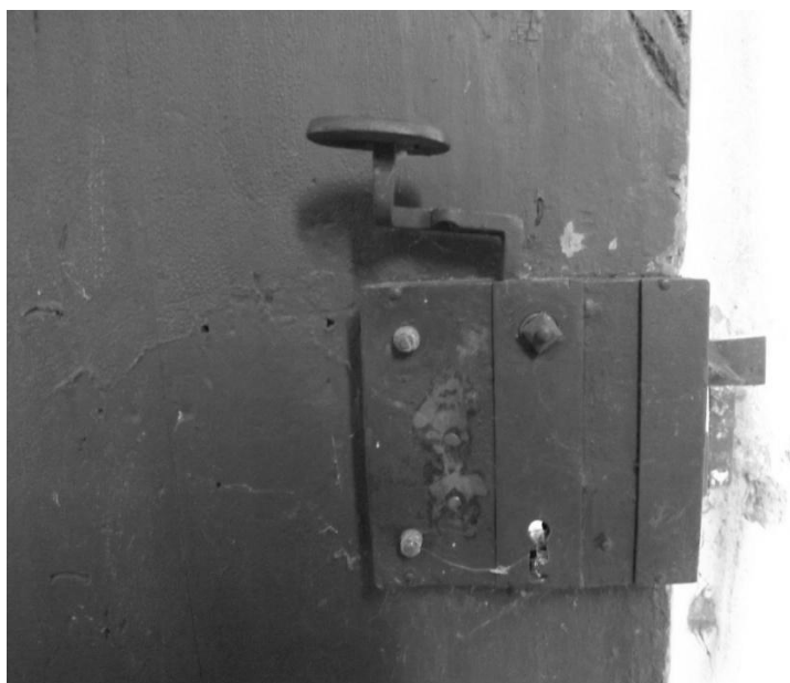
Obr. 21. Dveře v presbytáři, strana interiéru, krabicový zámek
