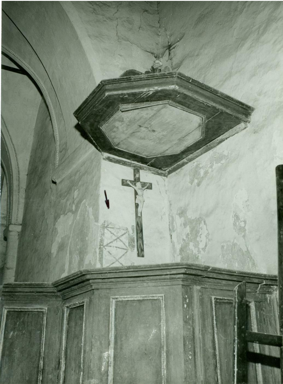
Obr. 33. Pohled na pravý kout u triumfálního oblouku s výmalbou (převzato z: NPU Plzeň)
