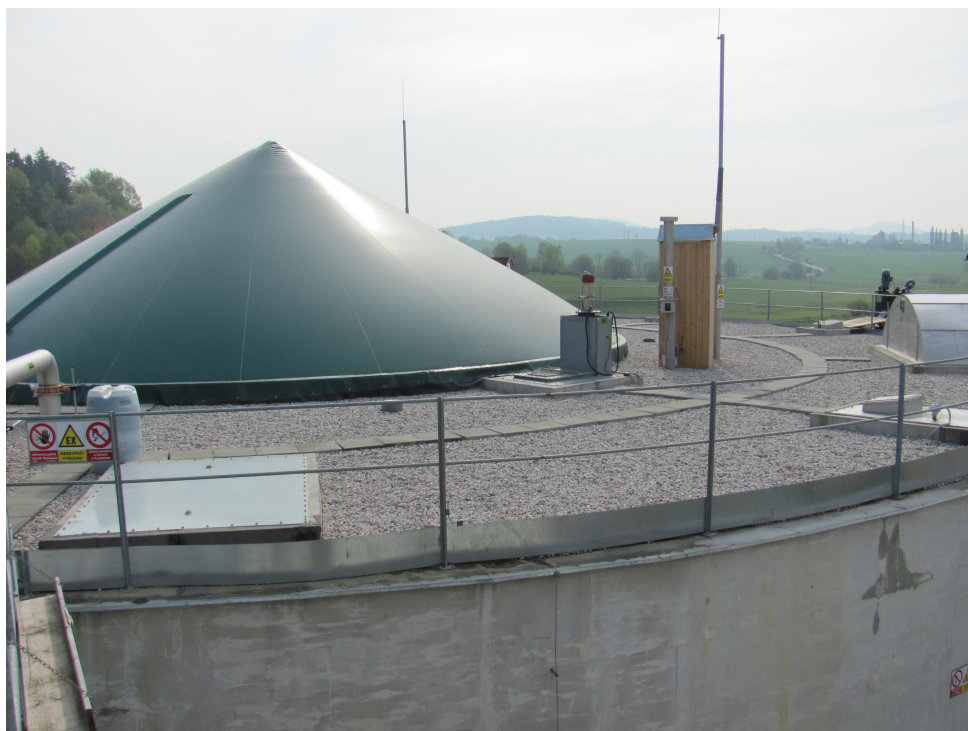
Obrázek 3: Pohled na střechu fermentoru
