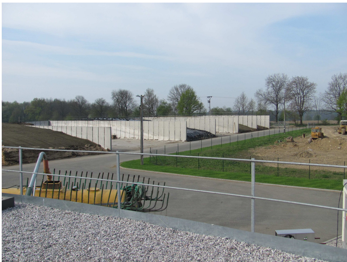
Obrázek 4: Sklad vstupních surovin – silážní jámy
