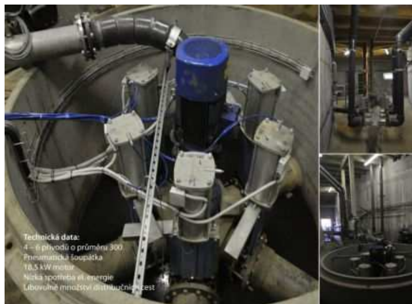
Obrázek 9: Centrální čerpadlo [11]
