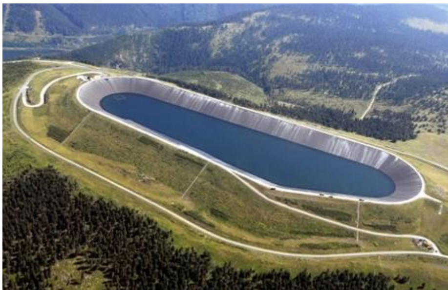
Obrázek 16: Přečerpávací vodní elektrárna Dlouhé stráně
