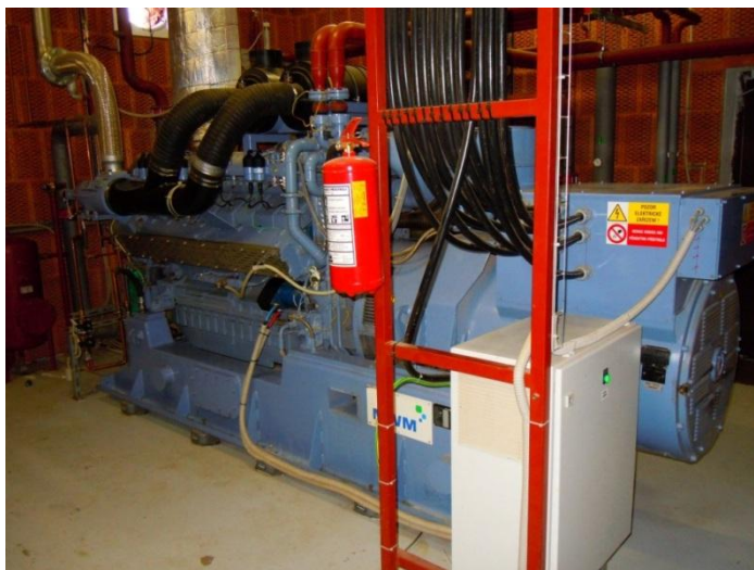
Obrázek 7: První kogenerační jednotka BPS Všeruby o výkonu 716 kW
