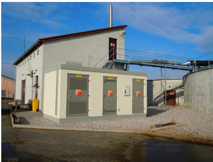
Obrázek 6: Technická budova s trafostanicí
