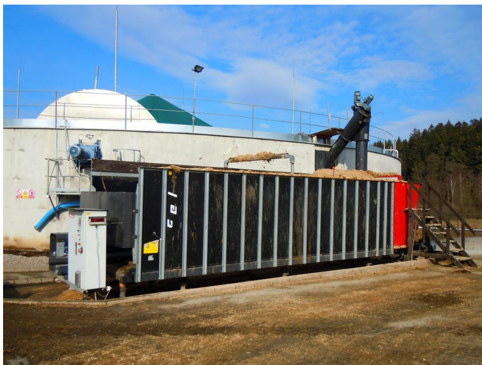
Obrázek 4: Fermentor s dávkovacím zařízením
