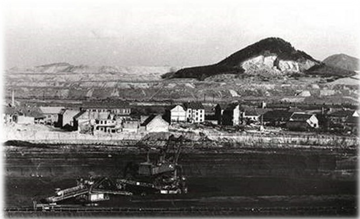
Obrázek 1.4 Demolice Starého Mostu [5]
