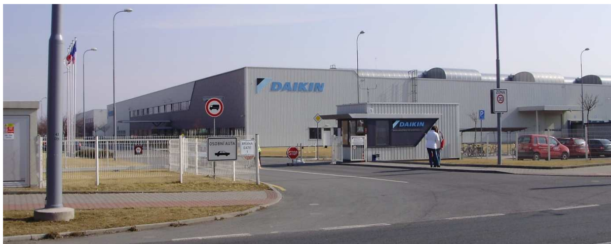
Obrázek 5-2: Daikin Industries Czech Republic, s.r.o. v Plzni
