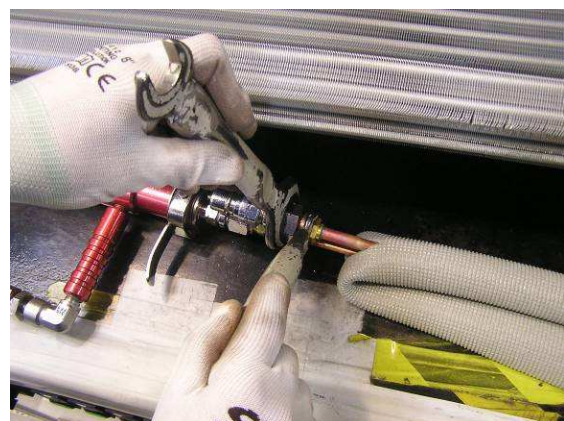
Obrázek 5-11: Povolení kapleru klíčem
