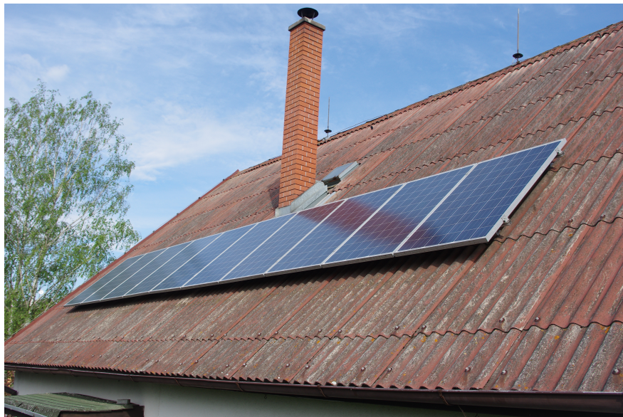
Obrázek 1.5: Umístění panelů na střeše
