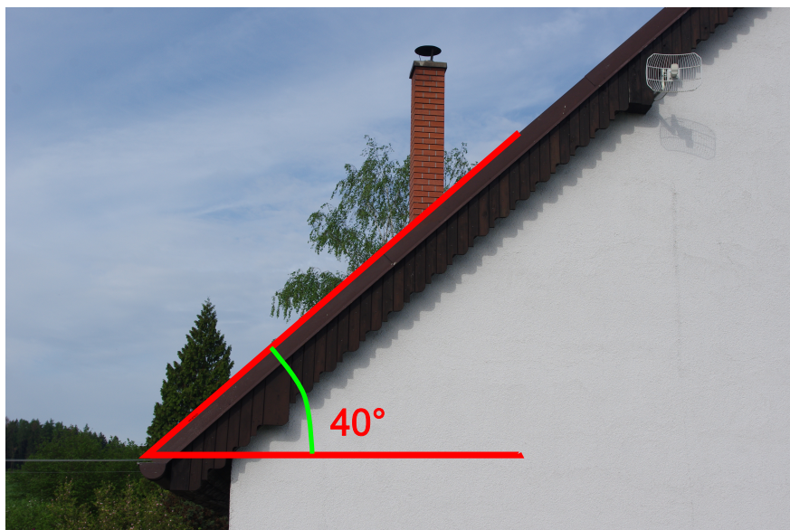
Obrázek 1.4: Změření úhlu sklonu instalace
