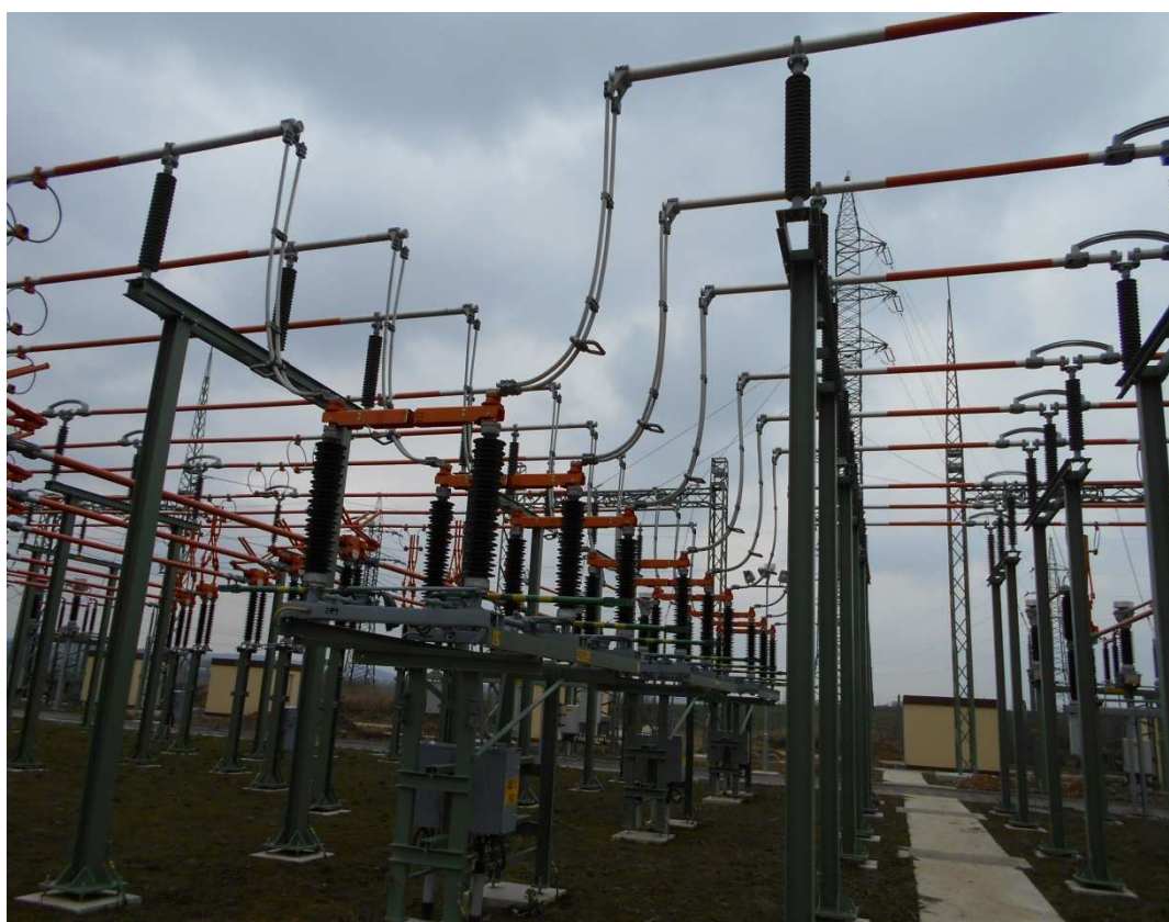
Obr. 10 Trojitý systém přípojnic 110 kV podélně dělený
