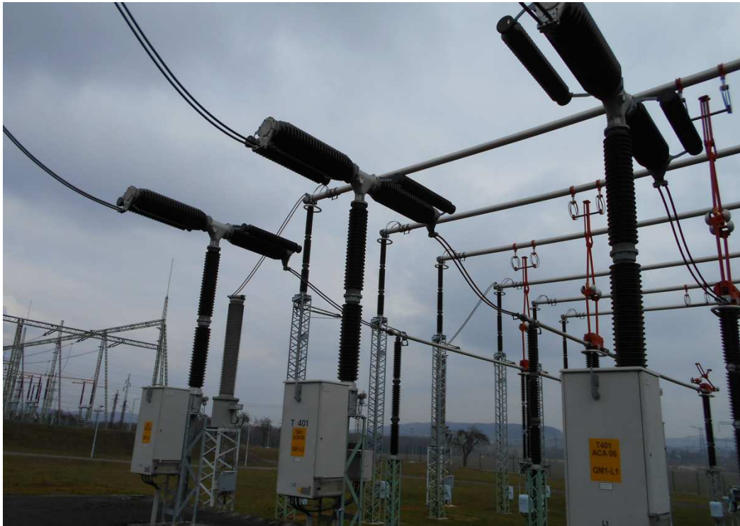
Obr. 5 Vypínač 400 kVs fluoridem sírovým SF 6
