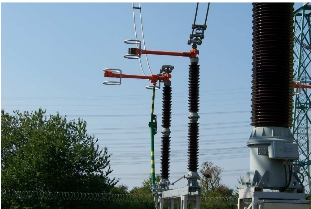
Obr. 6 Horizontální odpojovač se zemnicím nožem
